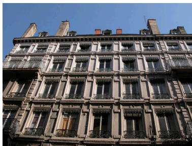
Façade principale rue Grenette, vue par-dessous Phot. Bernard Ducouret IVR82_20046900998NUCA
