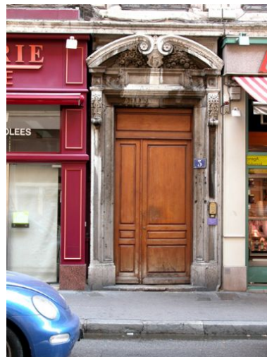
Façade principale, porte Phot. Bernard Ducouret IVR82_20046900999NUCA
