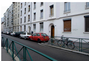
L'alignement des rez-de- chaussée soulignés d'un bandeau, le long de la rue Tourville Phot. Maryannick Chalabi IVR82_20096901210NUCA
