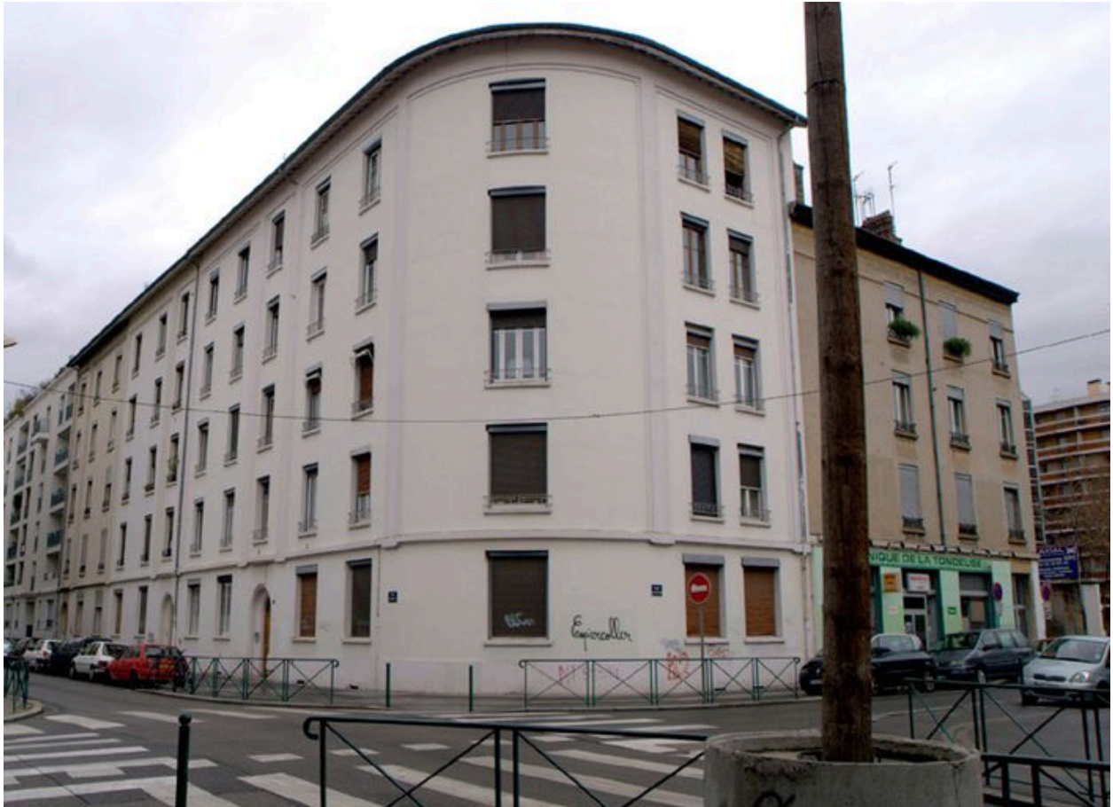
Vue générale depuis le sud-ouest, angle des rues Tourville et du Béguin
