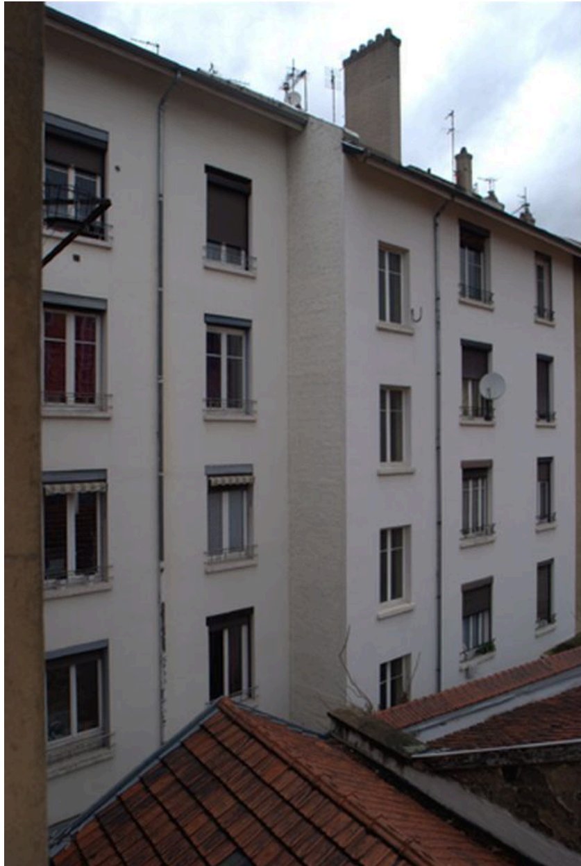
Vue de l'élévation postérieure
