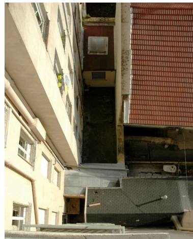
La cour vue depuis le 279 rue de Créqui Phot. Maryannick Chalabi IVR82_20076900448NUCA
