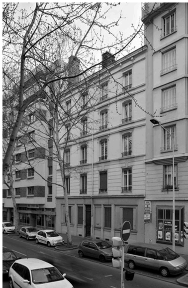
Vue générale depuis le nord-ouest Phot. Eric Dessert IVR82_20076901309NUC
