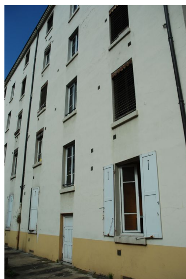
57 rue Pasteur, détail des accès sur cour
