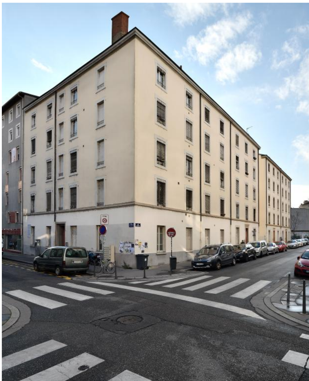
Alignement ouest, rue Pasteur
