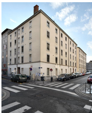
Alignement ouest, rue Pasteur Phot. Thierry Leroy IVR84_20186901108NUCAQ
