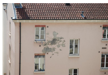
62 rue Pasteur, vue postérieure : mâchefer apparent dans une lacune de l'enduit Phot. Catherine Guillot IVR82_20126901007NUCA
