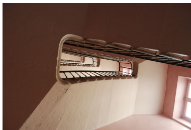
55-57 rue Pasteur : vue de l'escalier Phot. Catherine Guillot IVR82_20126901011NUCA
