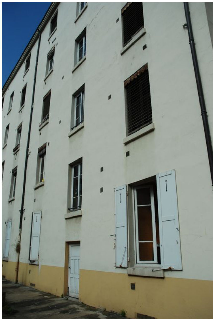
57 rue Pasteur, détail des accès sur cour
