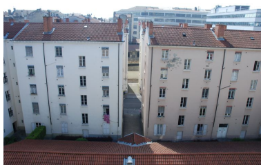
58-64 rue Pasteur, élévations sur cour Phot. Catherine Guillot IVR82_20126901006NUCA
