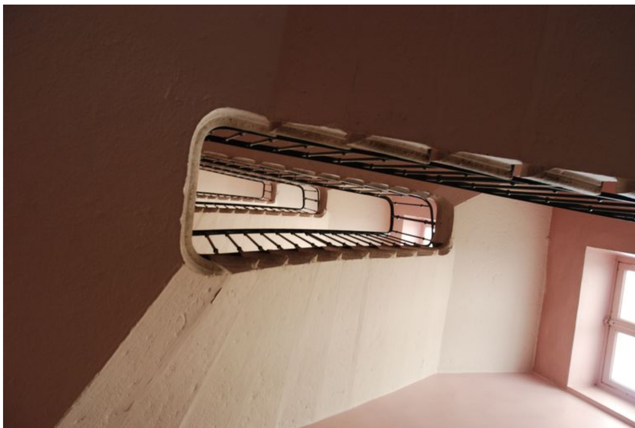
55-57 rue Pasteur : vue de l'escalier
