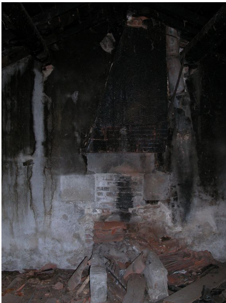
Vue intérieure du fournil.
