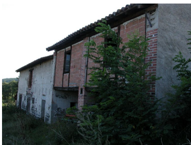
Vue du bâtiment de dépendances. Phot. Caroline Guibaud IVR82_20124203152NUCA
