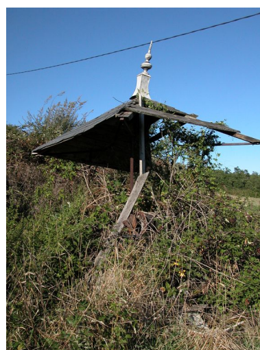
Vue du puits. Phot. Caroline Guibaud IVR82_20124203158NUCA
