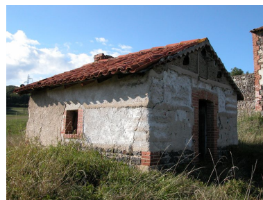
Vue du fournil. Phot. Caroline Guibaud IVR82_20124203154NUCA
