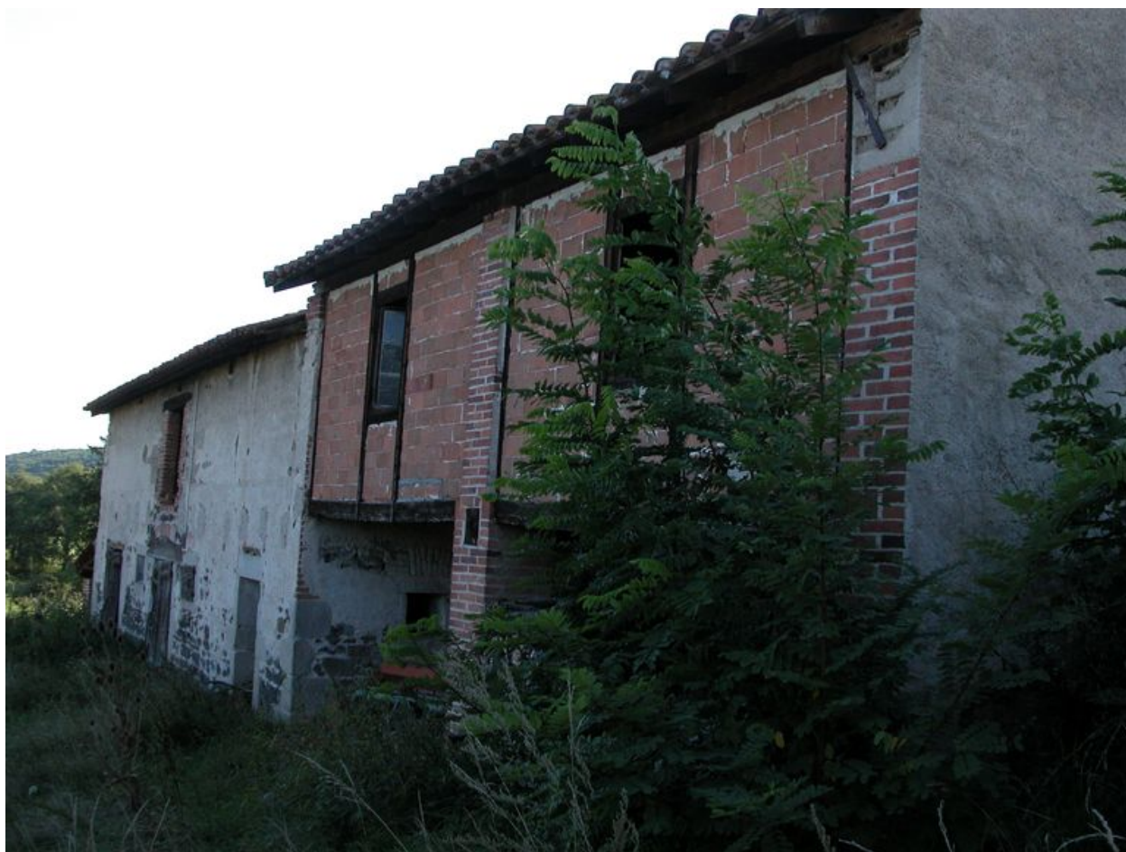
Vue du bâtiment de dépendances.
