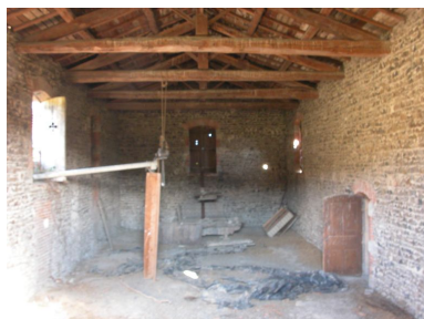
Vue intérieure du cuvage. Phot. Caroline Guibaud IVR82_20124203157NUCA
