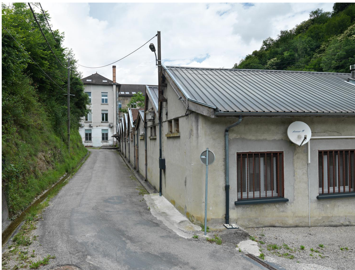
Espace de circulation du site
