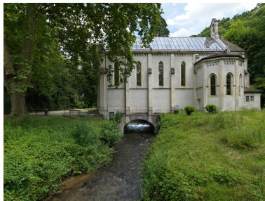
Vue de la chapelle-pont Phot. Thierry Leroy IVR84_20203800280NUCAQ
