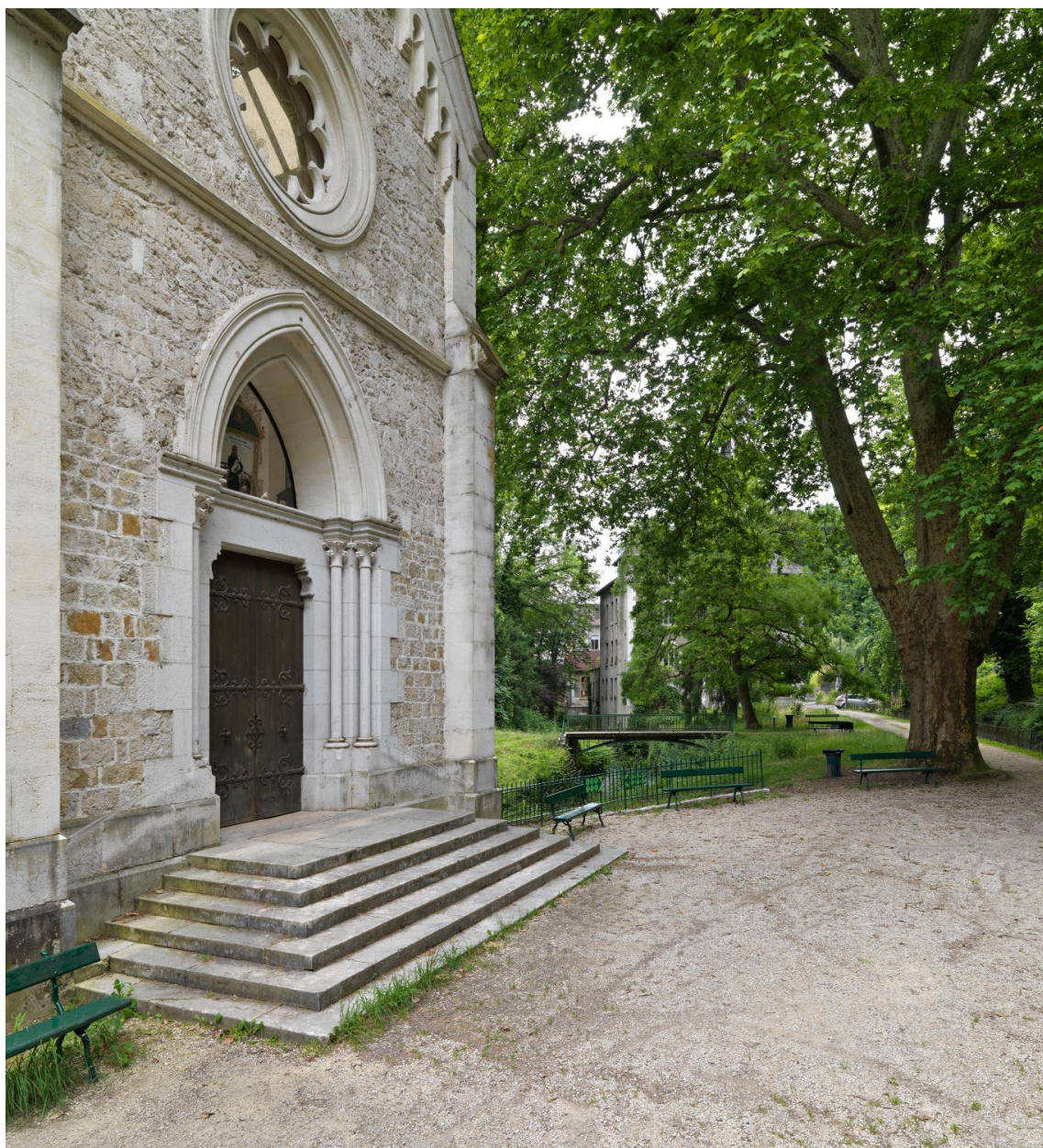
Détail entrée principale de la chapelle
