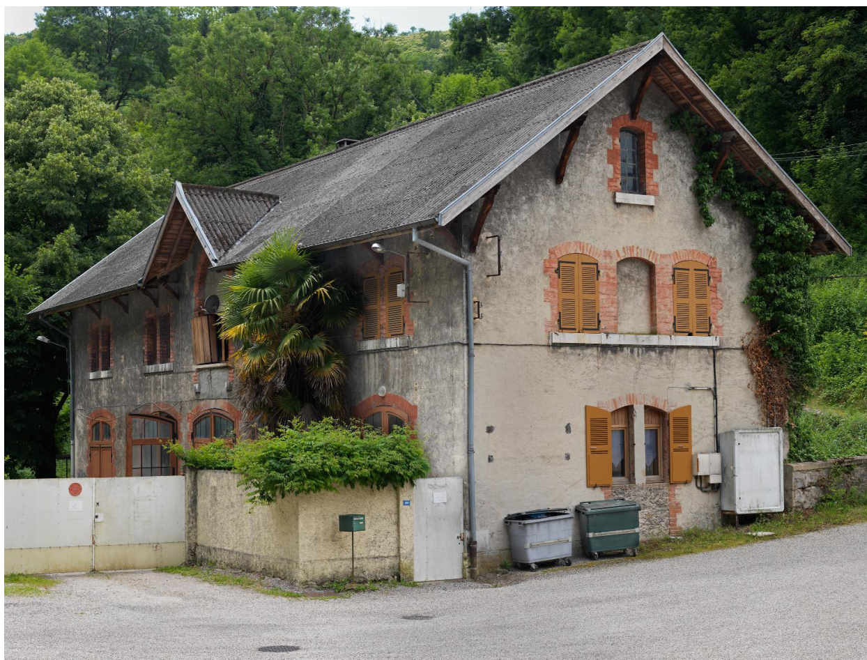
Logement localisé à l'entrée
