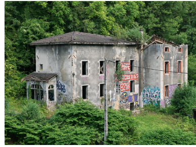
Bâtiment restant à l'abandon Phot. Thierry Leroy IVR84_20203800317NUCAQ
