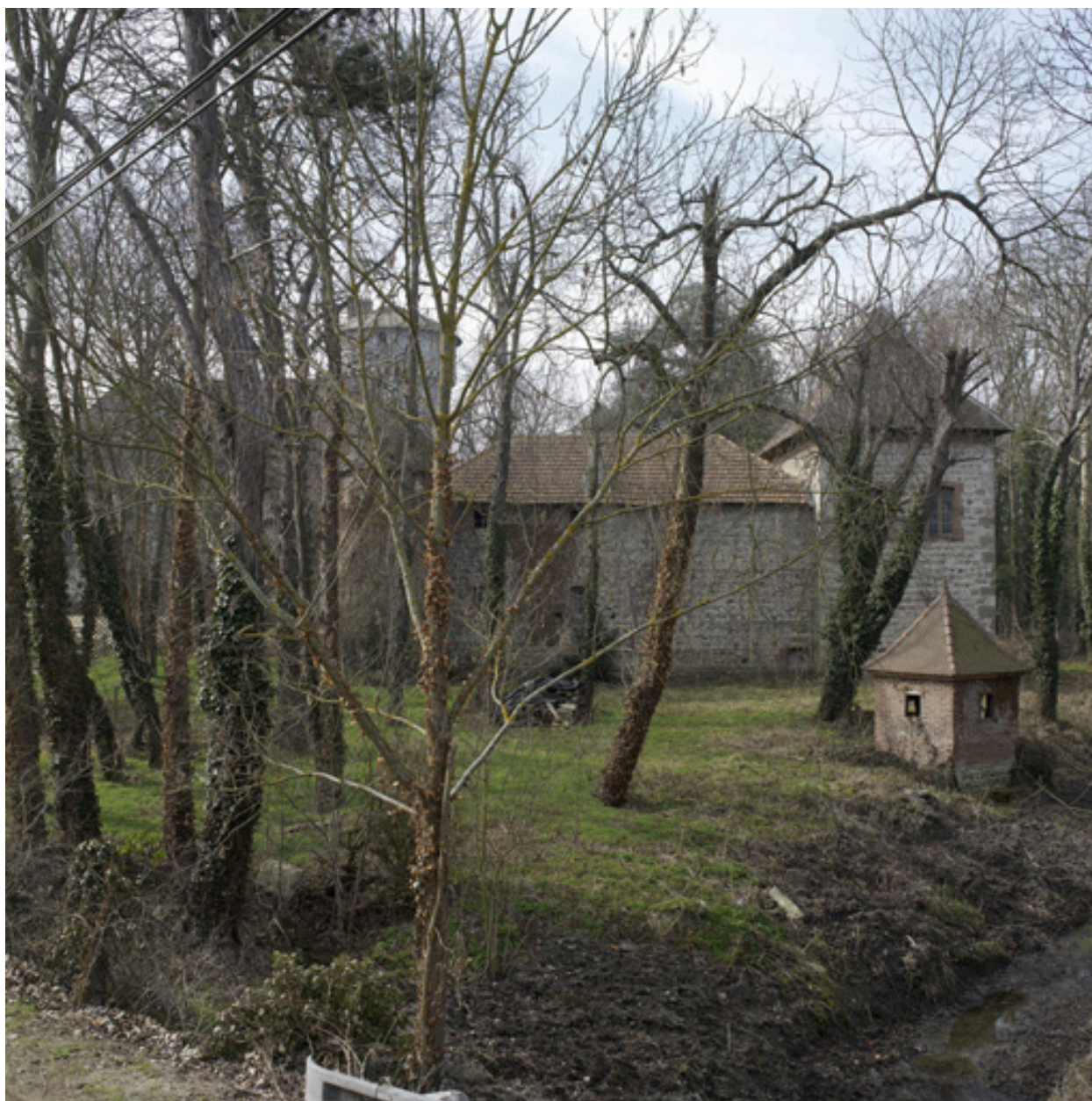
Vue d'ensemble du bâtiment ouest et du puits, depuis le chemin.
