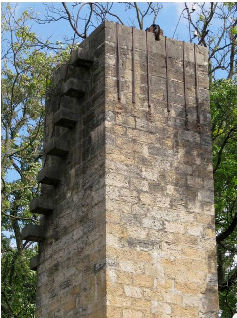
Pile droite, vue partielle : escalier et poulie au sommet (depuis le nord-ouest)
