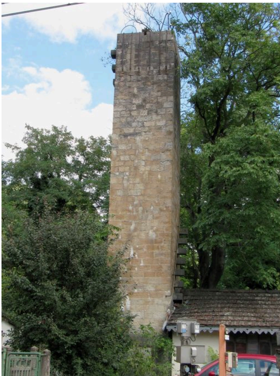
Pile droite, vue générale (depuis l'ouest)
