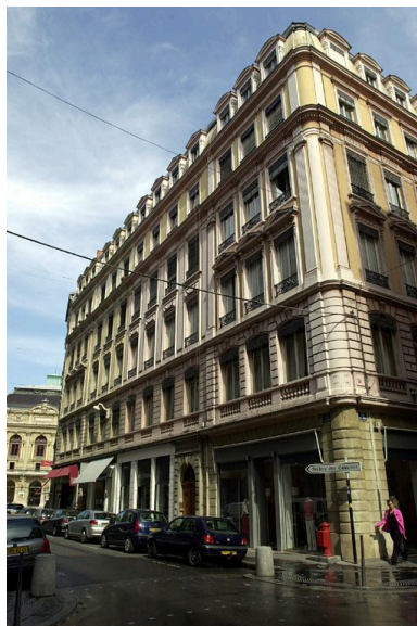
La rive impaire (n°s1, 3, 5) Phot. Véronique Belle IVR82_20066901582NUCA
