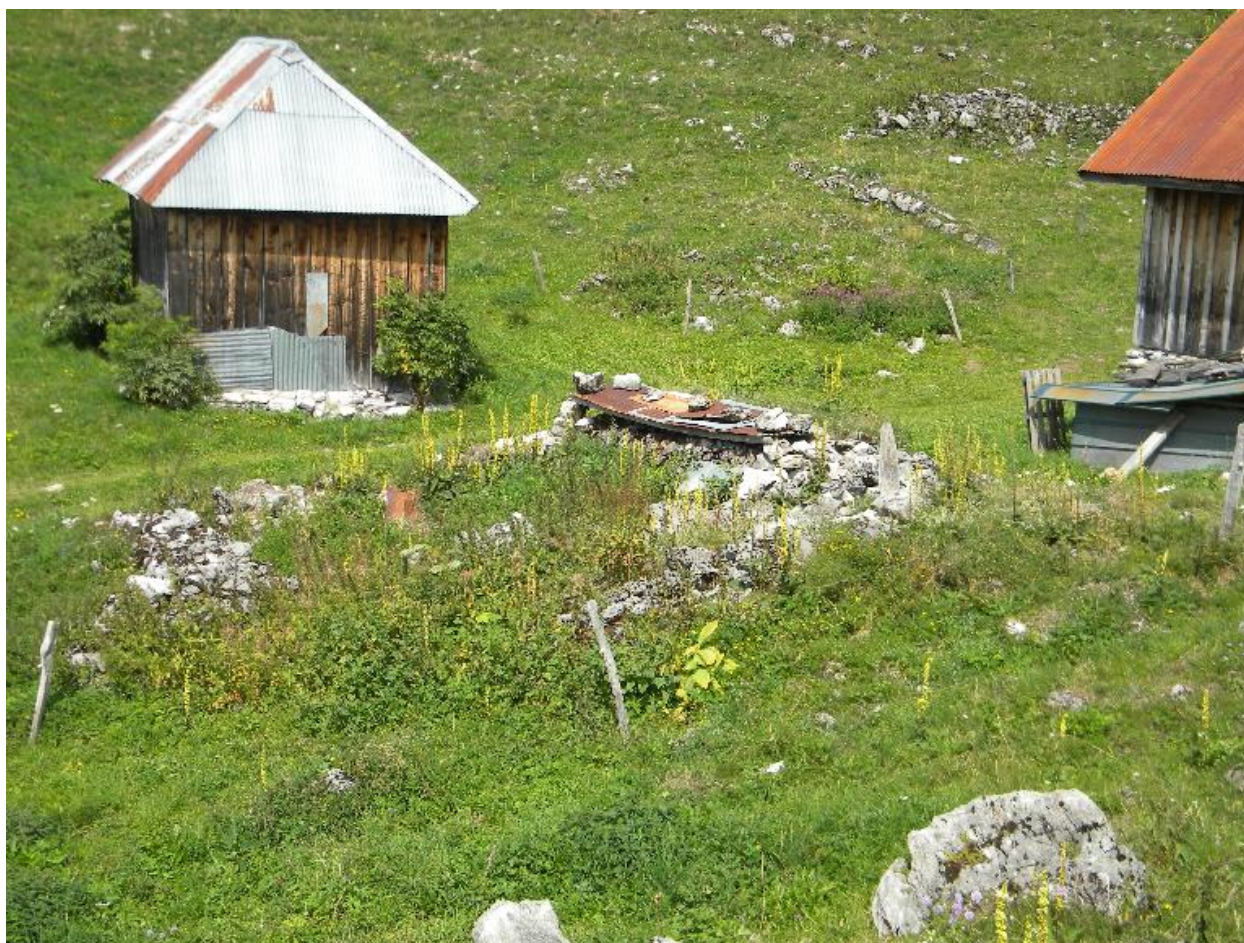
Vue des vestiges d'un bâtiment
