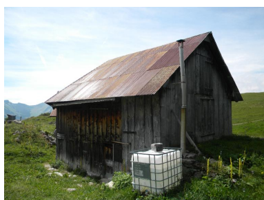
Détail d'une grange Phot. Jérôme Daviet IVR84_20167304258NUCA
