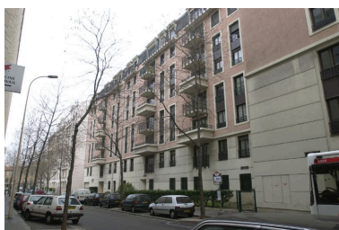
Elévation sur la rue Jean-Marie-Chavant Phot. Maryannick Chalabi IVR82_20046904326NUCA
