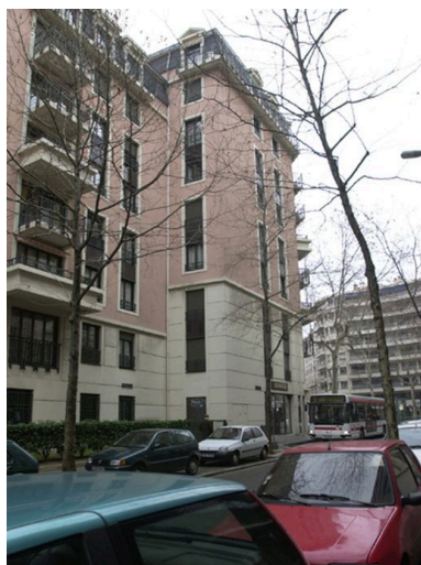
Elévation sur la rue Jean- Marie-Chavant depuis le sud Phot. Maryannick Chalabi IVR82_20046904328NUCA
