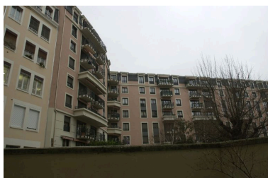
Vue de l'élévation postérieure depuis l'escalier du 3, avenue Jean-Jaurès Phot. Maryannick Chalabi IVR82_20046904329NUCA
