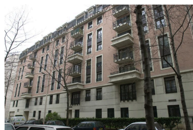
Elévation sur la rue Jean-Marie-Chavant (2) Phot. Maryannick Chalabi IVR82_20046904327NUCA
