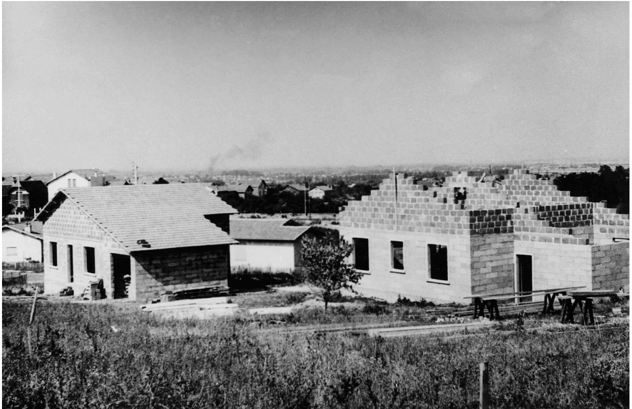
Maisons Castors en construction dans la cité de Rochefeuille, en 1952.
