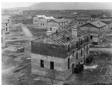
Chantier de construction de maisons ouvrières Michelin dans les années 1920. IVR84_20236300175NUC
