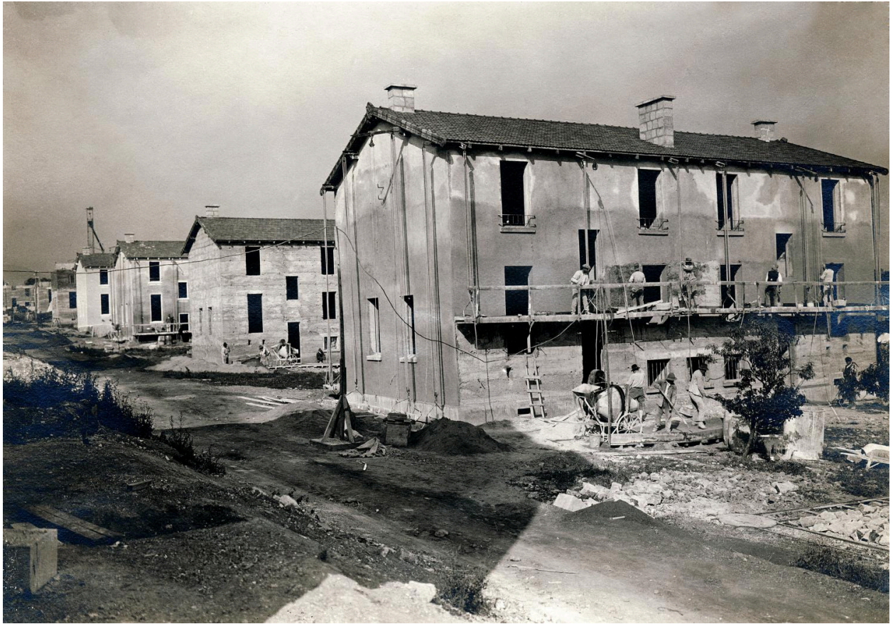
Chantier de la cité ouvrière Michelin de la Raye-Dieu en 1920.
