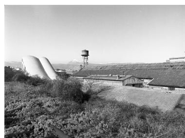
Bâtiments industriels et pistes d'essais du site Estaing détruit en 2005. Phot. Roger Choplain IVR83_20056300008X
