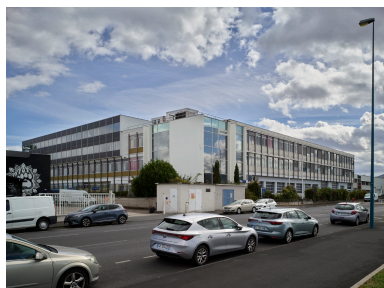
Bâtiment du site livreur Michelin du Brézet, désormais vendu. Phot. Christian Parisey IVR84_20226304575NUC4A
