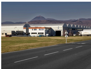
Vue partielle du site logistique de Chantemerle. Phot. Christian Parisey IVR84_20226300380NUCA
