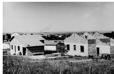
Maisons Castors en construction dans la cité de Rochefeuille, en 1952.
