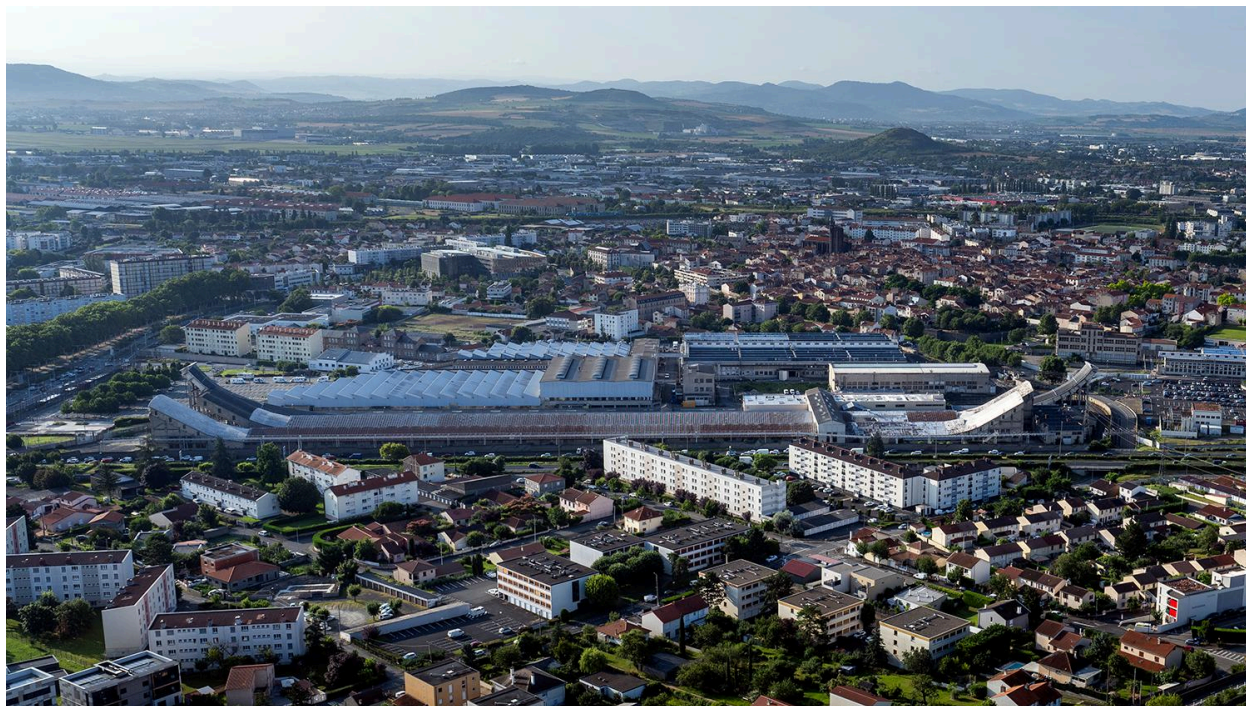
Quartier des pistes d'essais de l'usine Michelin de Cataroux, au cœur de l'agglomération clermontoise.
