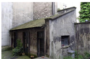
9 quai Perrache. Petite maison construite en fond de cour, derrière un immeuble, composée de 3 logements mono-cellulaire Phot. François Blanchetière IVR82_20016902050NUCA
