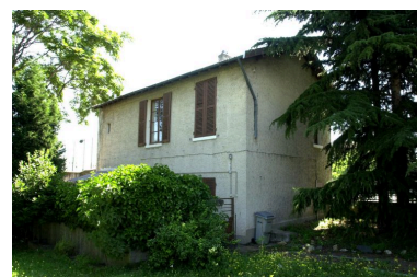
124 cours Charlemagne. Dernière maison de charbonnier subsistant dans le quartier du Confluent Phot. François Blanchetière IVR82_20016901845NUCA
