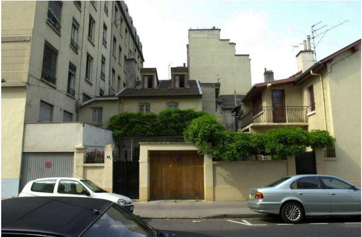
10 rue Ravat. Maison construite en retrait, à l'arrière d'une cour
