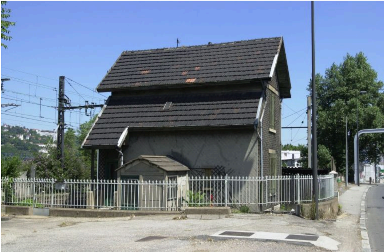
87 quai Perrache. Maison de garde-barrière
