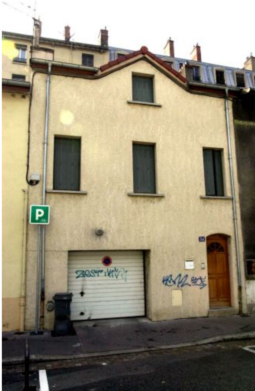
31 rue Seguin. Maison de ville mitoyenne, façade principale sur rue
