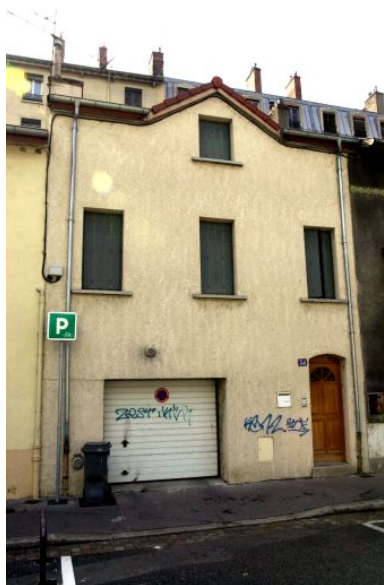
31 rue Seguin. Maison de ville mitoyenne, façade principale sur rue Phot. François Blanchetière IVR82_20016902174NUCA
