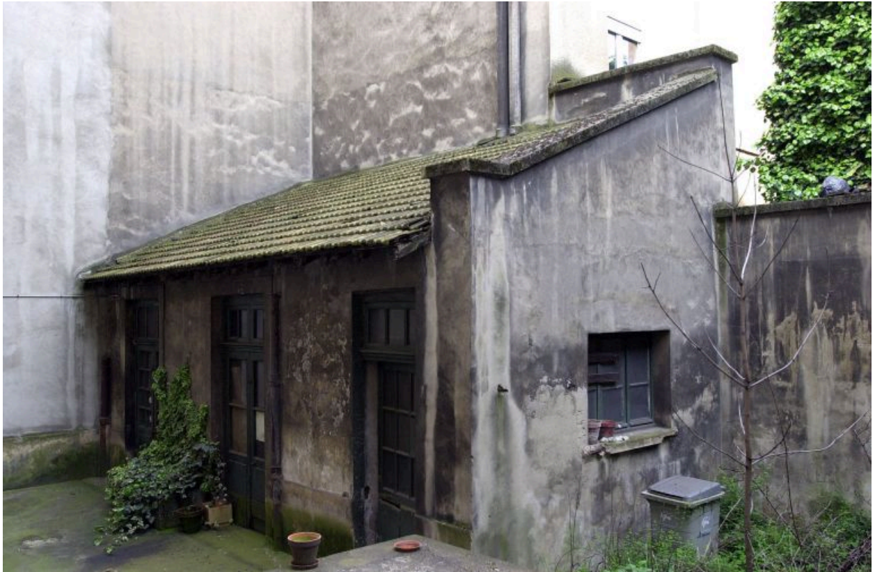
9 quai Perrache. Petite maison construite en fond de cour, derrière un immeuble, composée de 3 logements mono-cellulaire
