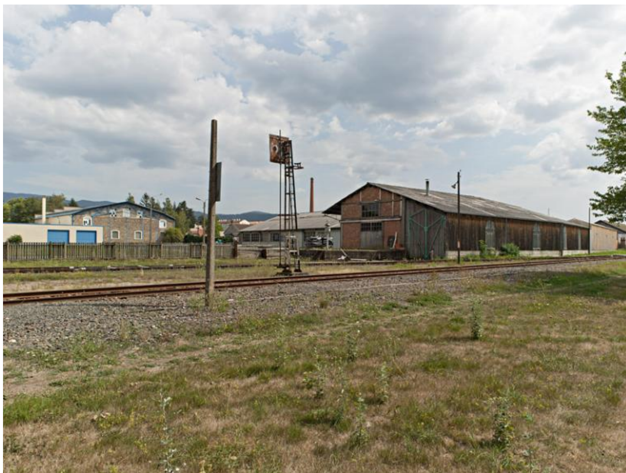
Zone industrielle d'Ambert et, en particulier, le musée de la machine agricole et à vapeur.
