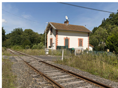
Maison de garde-barrière à la Sauvany, entre Olliergues et Pont-de-David, typique des bâtiments-types promus par la compagnie du PLM.
