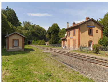
L'ancienne gare d'Olliergues et l'abri des voyageurs. Cette gare n'est plus en fonction mais elle a gardé son aspect et ses annexes d'origine, correspondant au plan-type du PLM des gares de 4e classe. Venant de Giroux, le train entrait en gare juste après la sortie d'un tunnel : ce fait était souligné en 1911 dans le guide Joanne.
