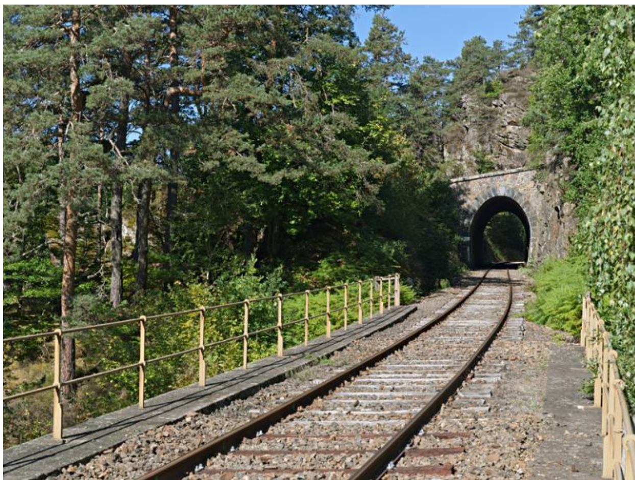
Petit tunnel à l'extrémité du viaduc du Merle.
