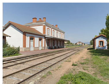
L'ancienne gare et l'abri de voyageurs d'Arlanc, édifiés selon le type "station de 2e classe" de la compagnie du PLM, comme la gare de Courpière sur cette même ligne.
