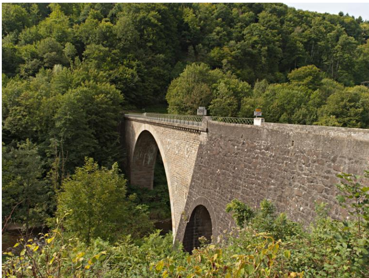
Pont routier enjambant la rivière de Dore et la voie ferrée, à proximité de Giroux-Gare.
