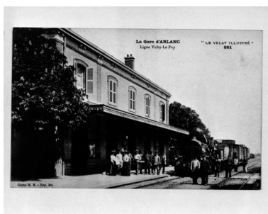
"La Gare d'ARLANC. Ligne Vichy - Le Puy." Autr. Roger Choplain, Autr. Roland Maston IVR83_19886300300X
