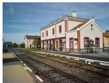
Gare de Pont-de-Dore (commune de Peschadoires), côté voies. La gare de Pont-de-Dore illustre le modèle de gare de voyageurs pour "station de 2e classe", sur laquelle a été greffée une petite annexe basse, au sud. Phot. Christian Parisey
