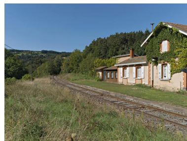
L'ancienne gare de Mayres au lieu-dit le Procureur. Entre Arlanc et la commune de Mayres, la voie s'est élevée de près de 400 m et les divers guides, au XIXe comme au XXe s. vantent les "magnifiques gorges de la Dore supérieure" que domine alors la voie.
