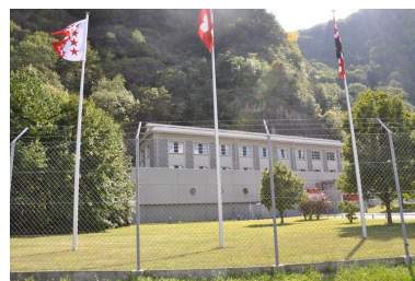
Façade antérieure de la centrale hydroélectrique de Vernayaz
