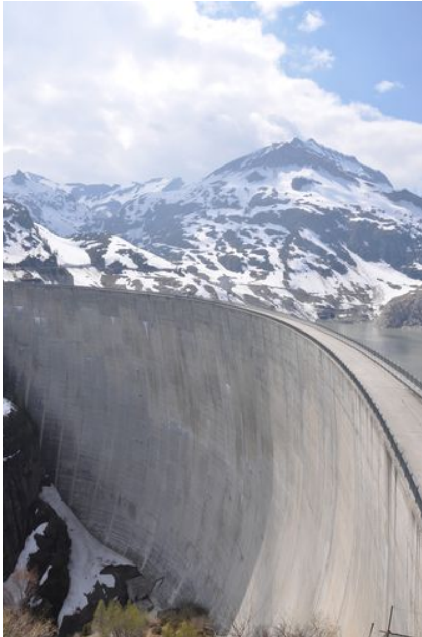
Vue du barrage voûte prise depuis la Gueulaz
