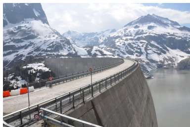
Vue de la crête du barrage voûte Phot. Samir Mahfoudi, Autr. Samir Mahfoudi IVR82_20117401243NUCA
