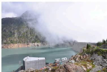
La prise d'eau du Nant de Drance avant immersion Phot. Samir Mahfoudi, Autr. Samir Mahfoudi IVR82_20117401249NUCA
