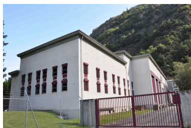
Remise ouvrant sur la cour intérieure de la centrale hydroélectrique de Vernayaz
