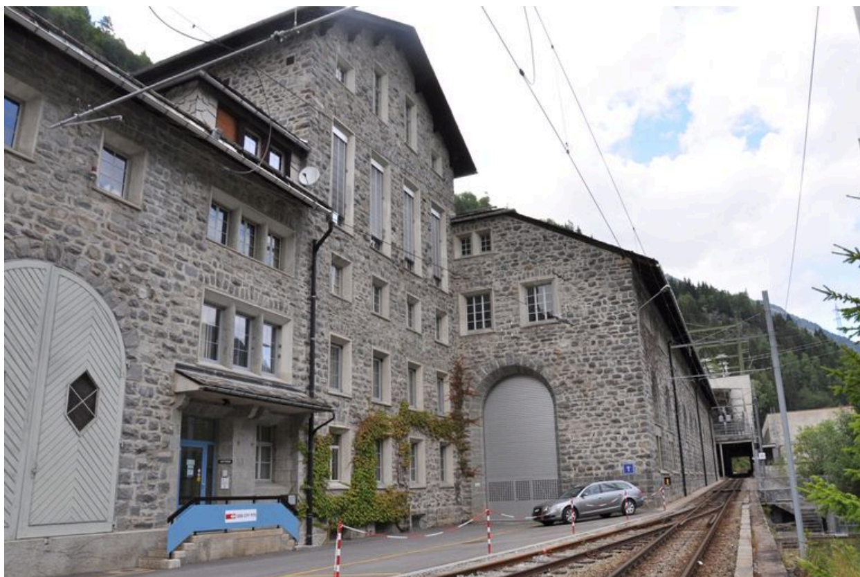
Bâtiment des bureaux adossé à la salle des machines de l'usine CFF du Châtelard
