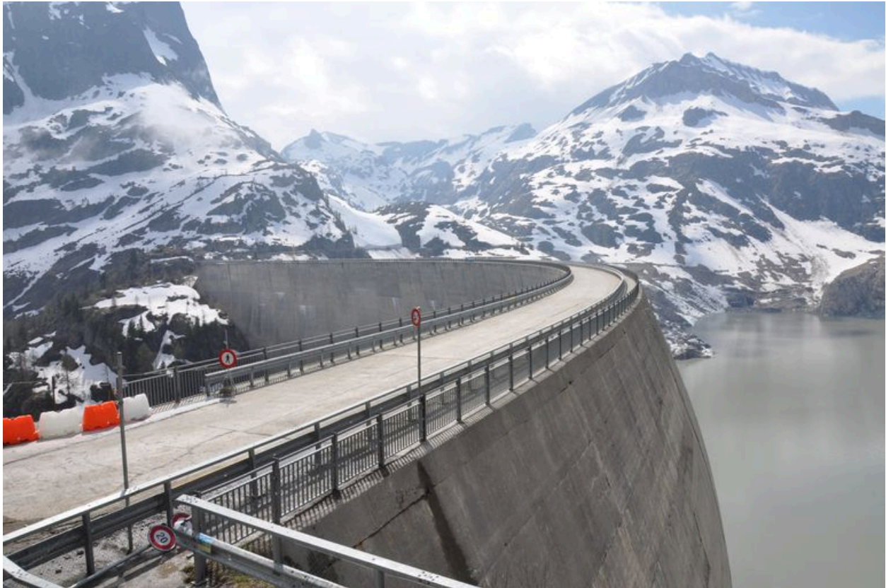
Vue de la crête du barrage voûte
