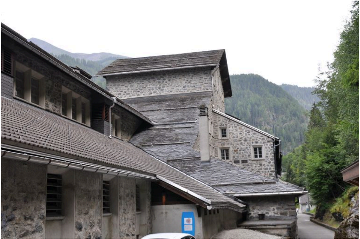
Façade postérieure de l'usine CFF du Châtelard
