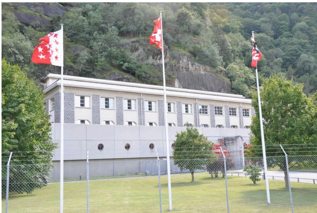
Bâtiment de la salle des machines de la centrale hydroélectrique de Vernayaz
