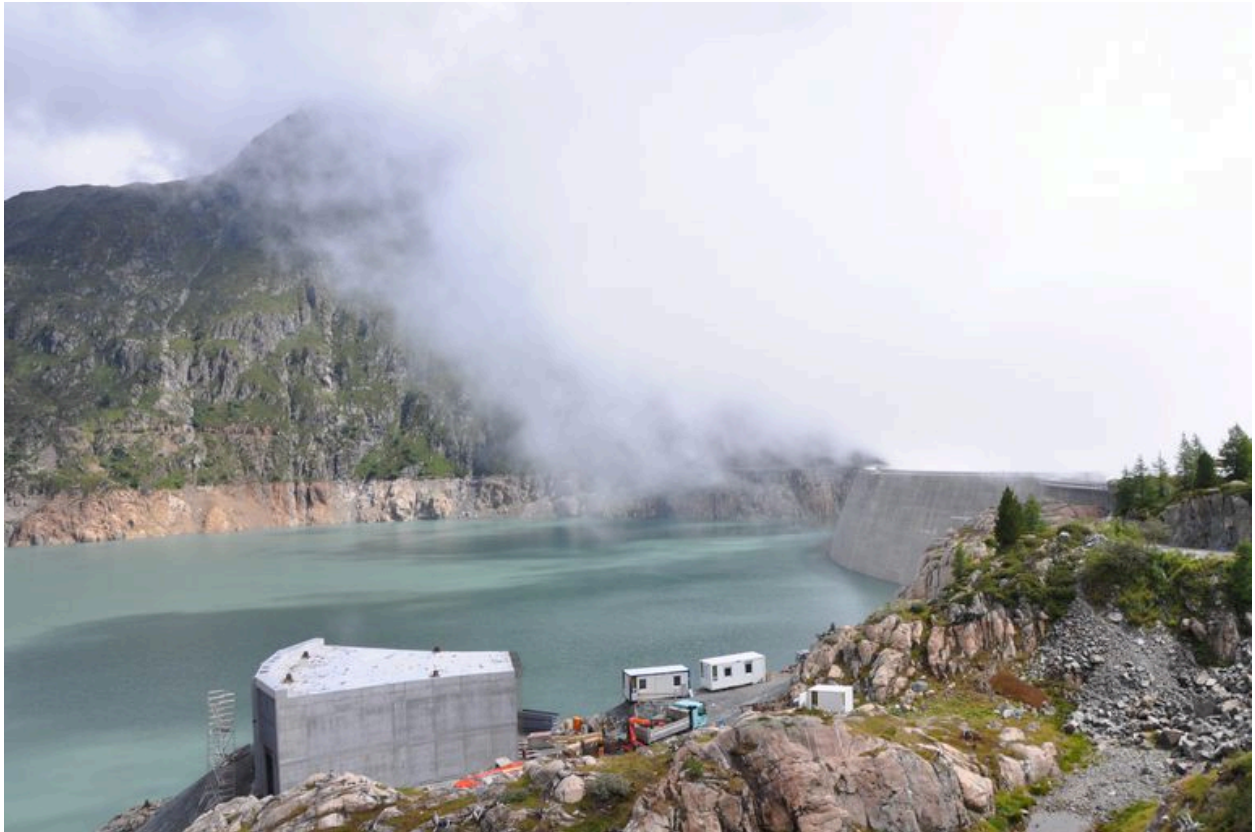
La prise d'eau du Nant de Drance avant immersion
