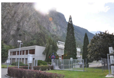
Vue d'ensemble de la centrale hydroélectrique de la Bâtiaz
