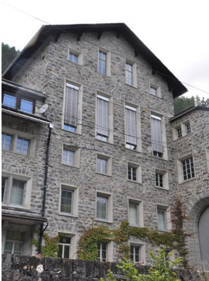
Bâtiment des bureaux de l'usine CFF du Châtelard
