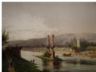
Détail Phot. Lionel Sauzade IVR84_20216301000NUCA
