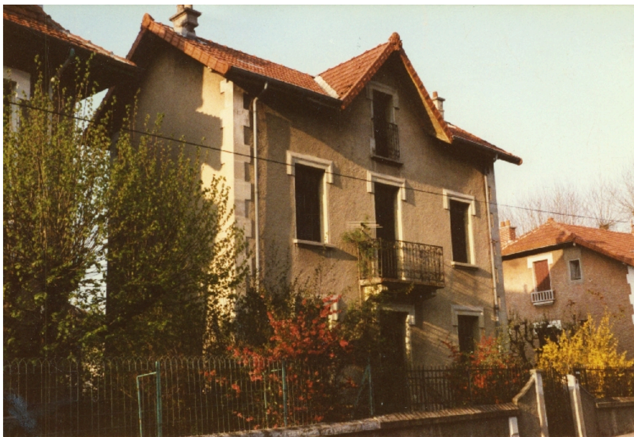
Vue de trois quart avant démolition
