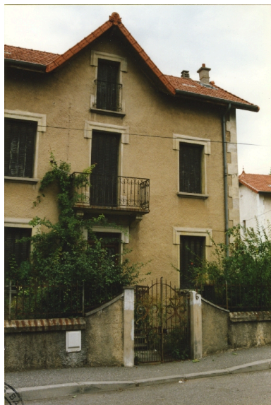
Façade principale avant démolition Repro. François Fouger IVR82_20127300766NUCB
