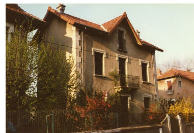
Vue de trois quart avant démolition Repro. François Fouger IVR82_20127300764NUCB
