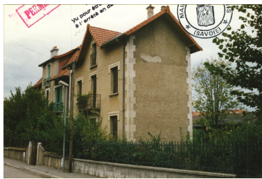
Vue de trois quart avant démolition Repro. François Fouger IVR82_20127300765NUCB
