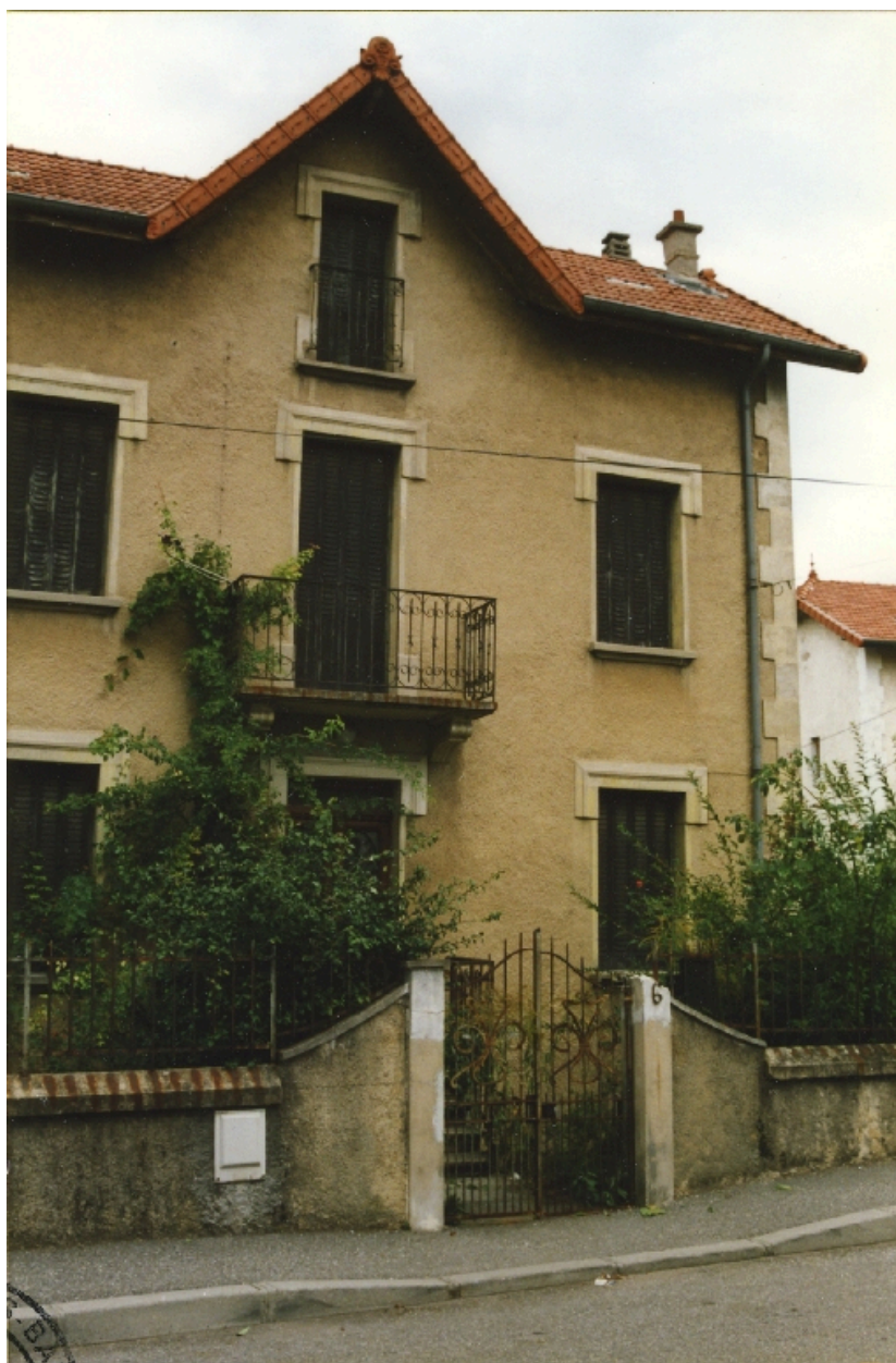
Façade principale avant démolition
