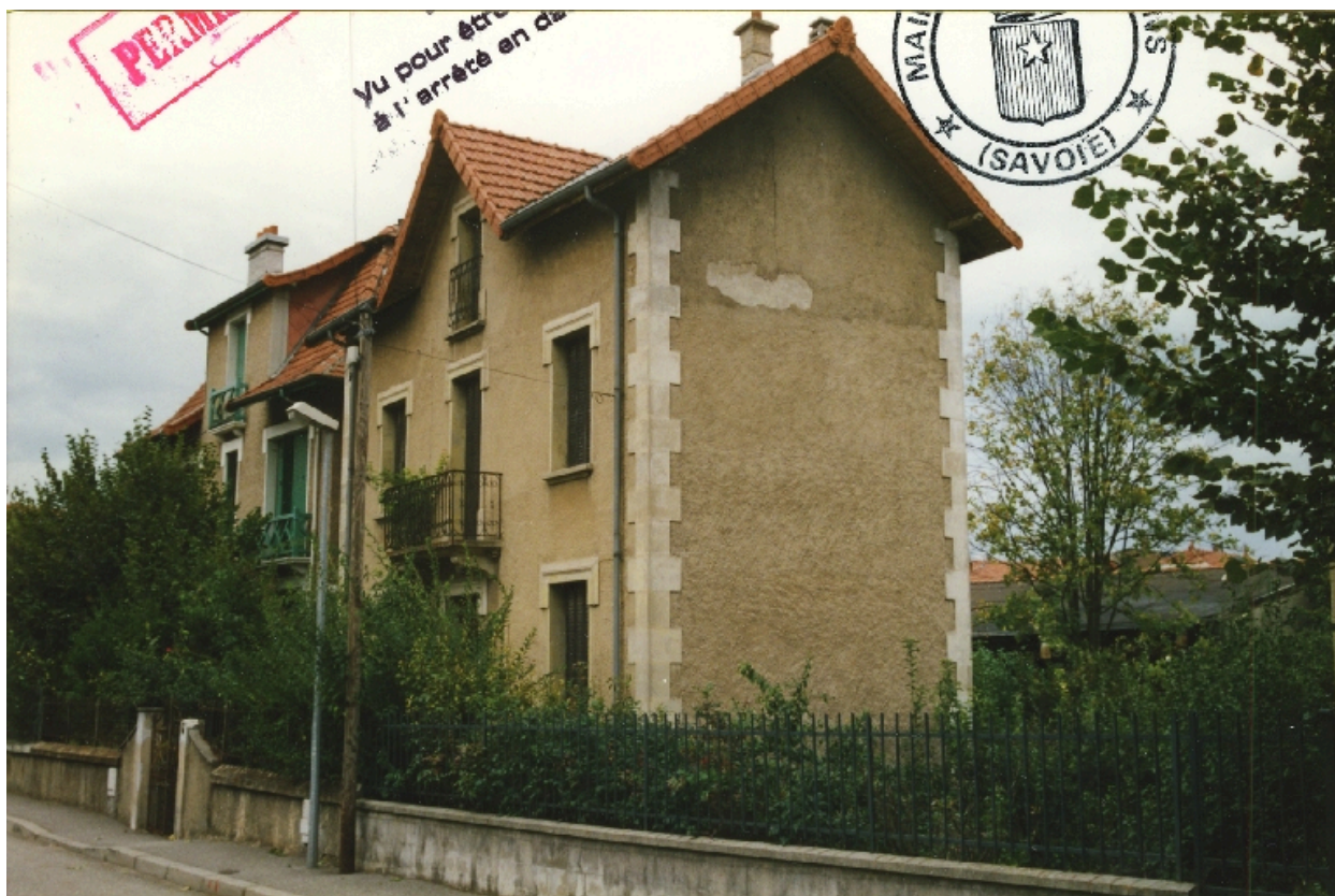
Vue de trois quart avant démolition
