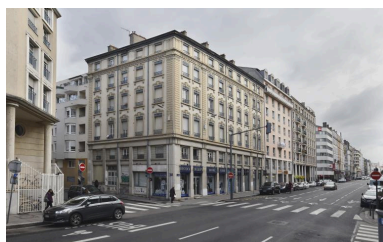
Vue de situation depuis l'ouest Phot. Franck Trabouillet IVR84_20186901178NUCAQ
