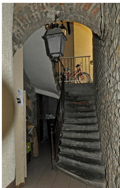
Vue intérieure, le départ de l'escalier Phot. Magali Delavenne IVR84_20176901525NUCA
