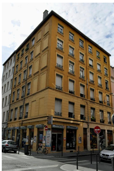
Vue d'ensemble, prise depuis le nord Phot. Magali Delavenne IVR84_20176901522NUCA
