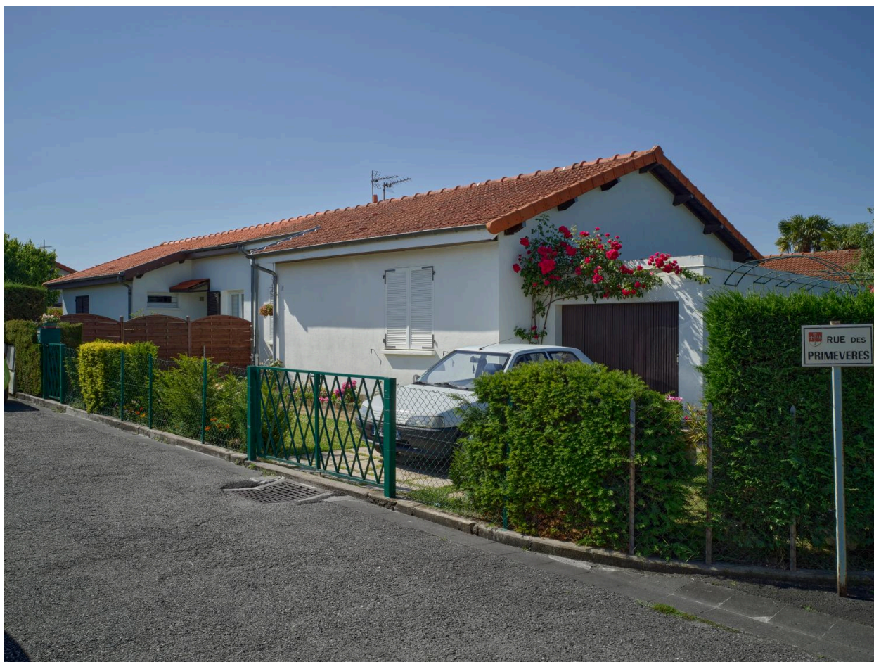
Vue partielle d'un ensemble de quatre maisons regroupées en H, rue des Primevères (construction en 1972-1973).
