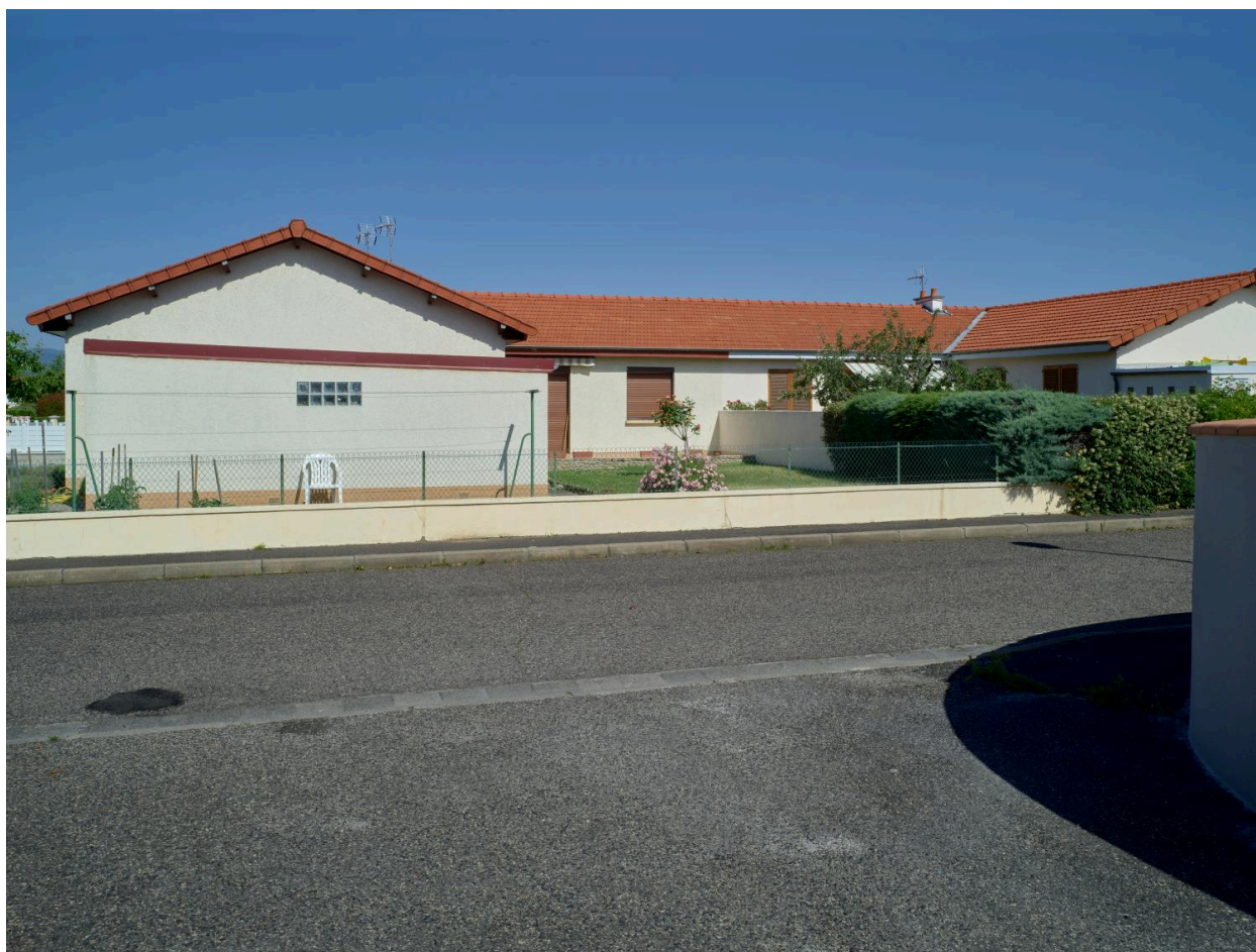
Vue latérale d'un ensemble de maisons disposées en H, rue des Coquelicots (construction en 1972-1973).
