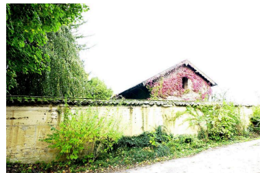
Vue partielle de la grange depuis l'allée Phot. Bernard Ducouret IVR82_20016902889NUCA
