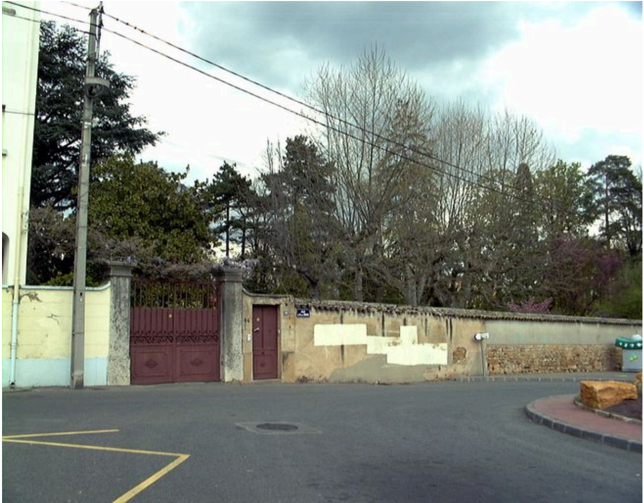
Vue du portail et du mur de clôture
