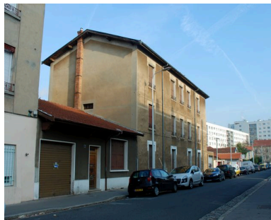
Vue générale depuis le sud-ouest. Phot. Catherine Guégan IVR82_20116902611NUCA
