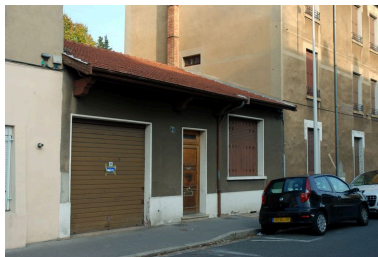
Vue de l'immeuble depuis le nord-est. Phot. Catherine Guégan IVR82_20116902612NUCA
