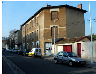
Détail de la maison. Phot. Catherine Guégan IVR82_20116902613NUCA
