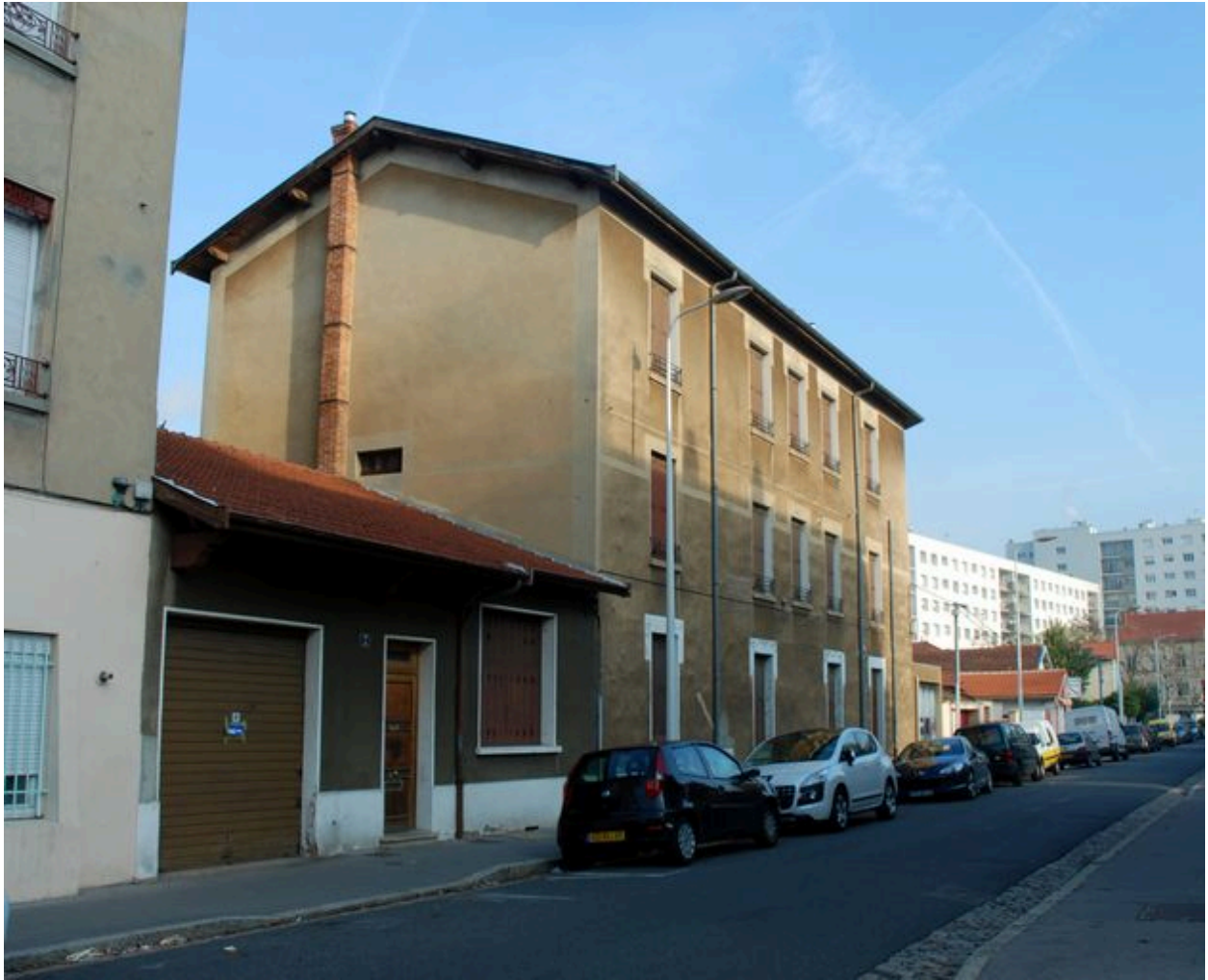
Vue générale depuis le sud-ouest.
