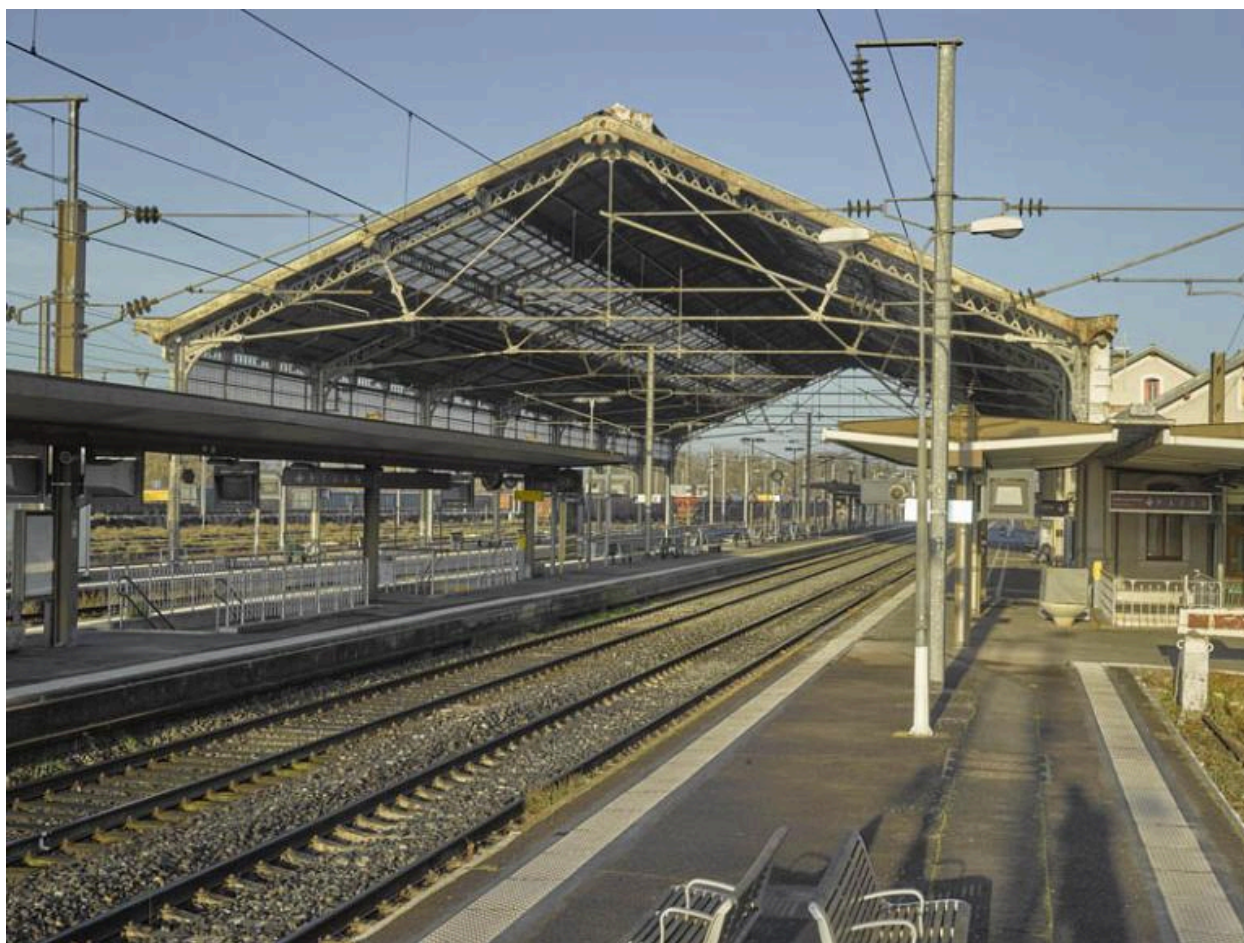
La grande verrière à structure métallique (système de fermes "Polonceau") protégeant les voies et les quais de la gare de Saint-Germain-des-Fossés.
