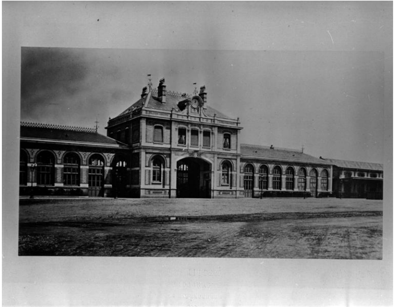
La gare de Vichy. Photographie par Paul [COUTEN], s.d. In : Album des travaux du Casino, 1863-1865.
