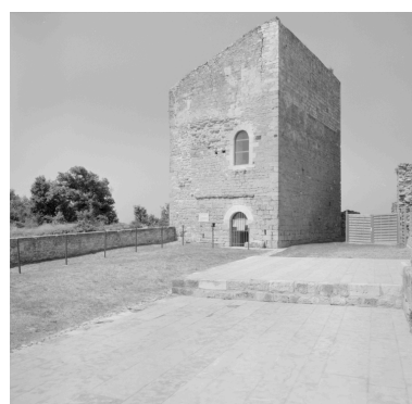
Vue du pigeonnier depuis l'est. Phot. Alain Franchella IVR82_19992600247X
