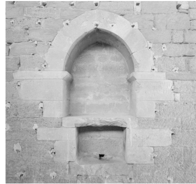
Mur nord, vestiges d'un évier roman. Phot. Alain Franchella IVR82_19992600285X
