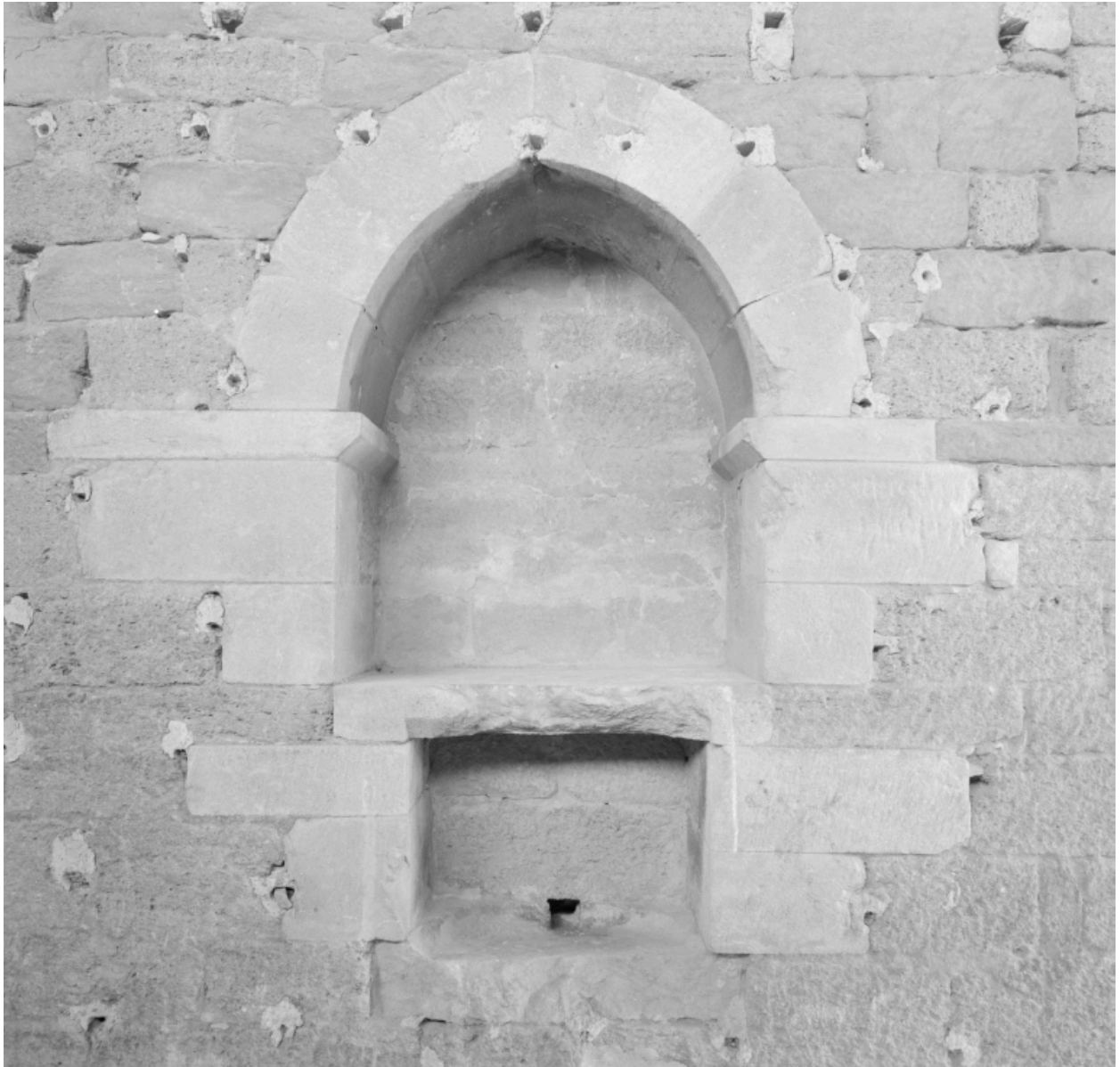
Mur nord, vestiges d'un évier roman.
