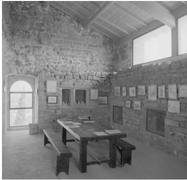
Mur est, vue intérieure aujourd'hui salle d'exposition. Phot. Alain Franchella IVR82_19992600283X
