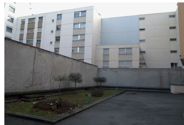
Elévation postérieure, vue partielle Phot. Maryannick Chalabi IVR82_20116904103NUCA
