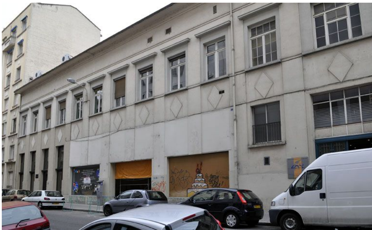
Façade antérieure depuis l'Est.
