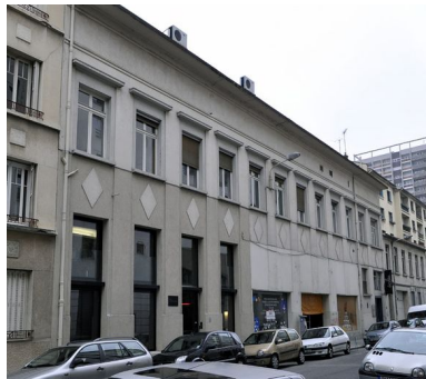
Vue générale Phot. Julien Defillon IVR82_20106900824NUCA
