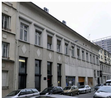
Vue générale Phot. Julien Defillon IVR82_20106900824NUCA
