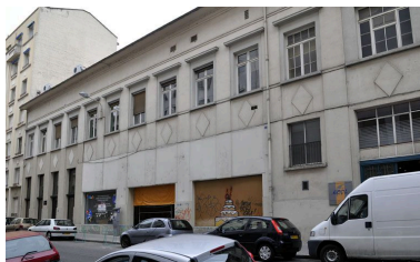
Façade antérieure depuis l'Est. Phot. Julien Defillon IVR82_20106900825NUCA
