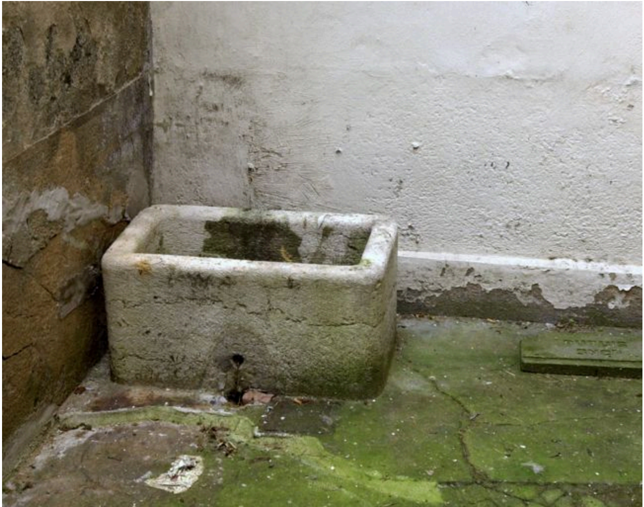
Bassin de pierre dans la cour
