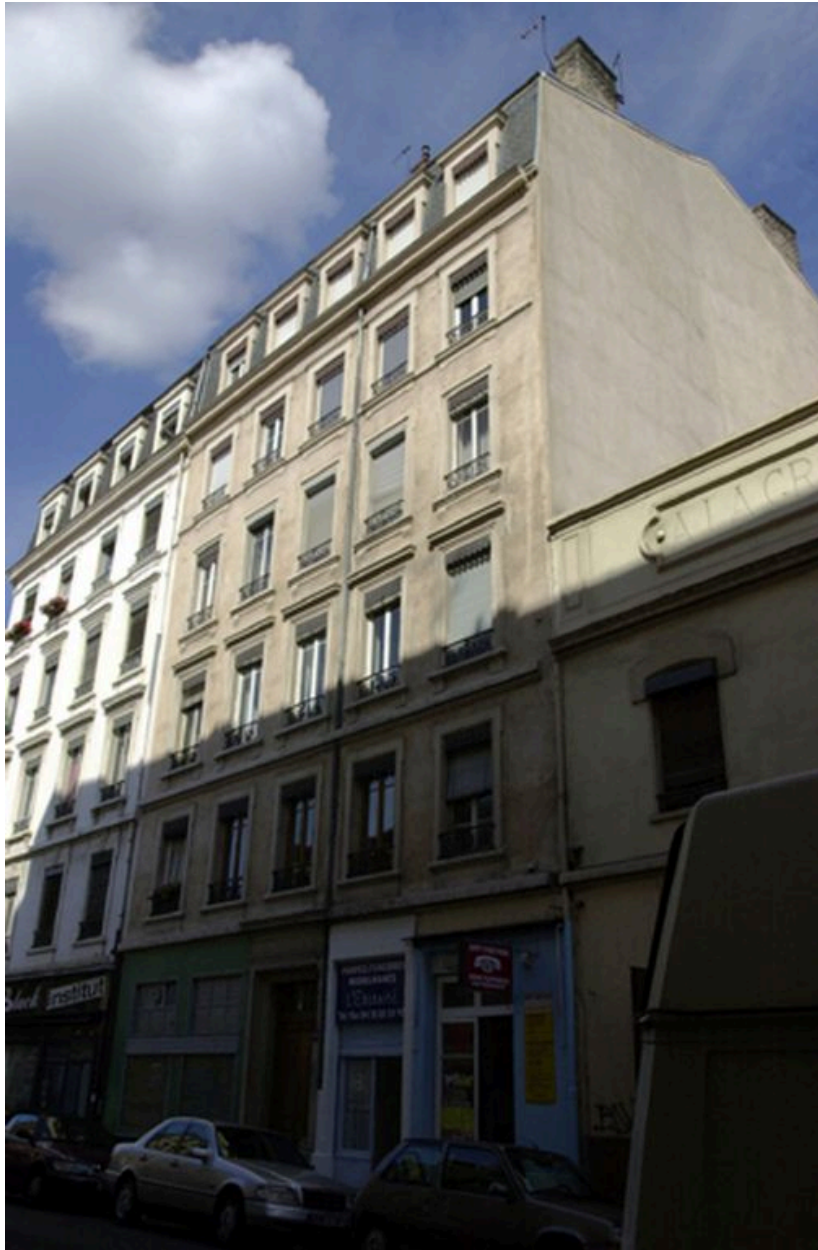
Élévation principale depuis le nord-est
