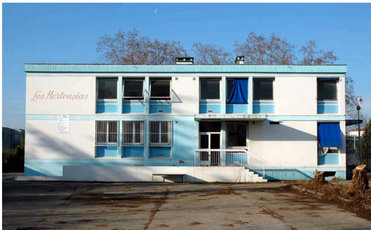
Vue des logements de fonction
