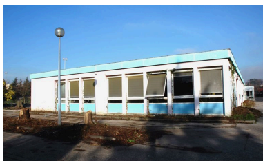
Vue générale du bâtiment scolaire Phot. Véronique Belle IVR82_20066900757NUCA
