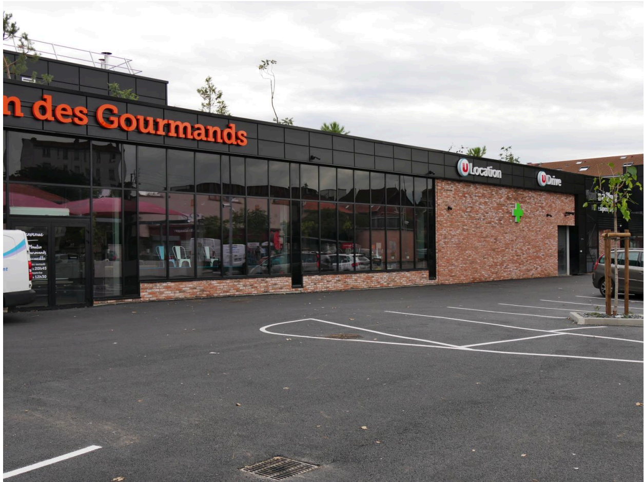
Usine du 8e arrondissement de Lyon transformée en supérette
