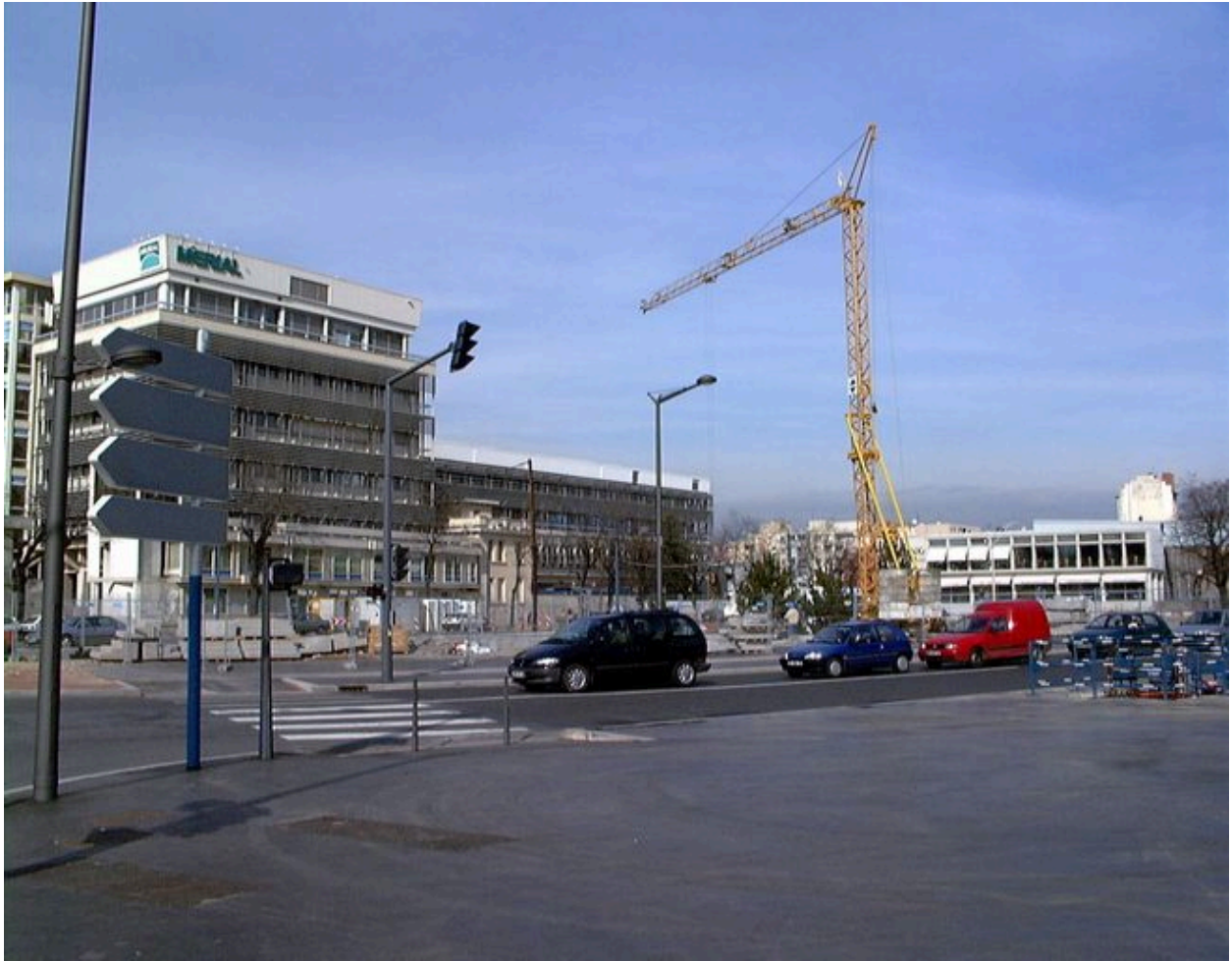
Le square en chantier (3 mars 2000)
