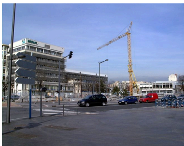
Le square en chantier (3 mars 2000) Phot. Véronique Belle IVR82_20006900476NUCA
