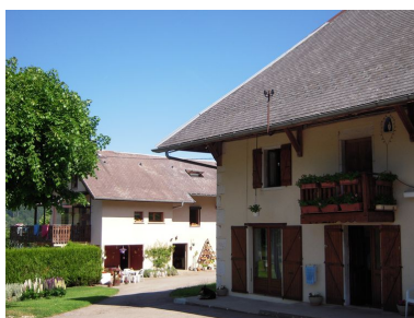
Vue de l'extrémité ouest du bâtiment principal et aperçu du bâtiment annexe transformé en habitation. Phot. Clémence Serve IVR82_20117400834NUCA
