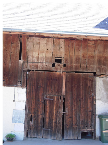
Vue de la porte de la grange. Phot. Clémence Serve IVR82_20117400835NUCA
