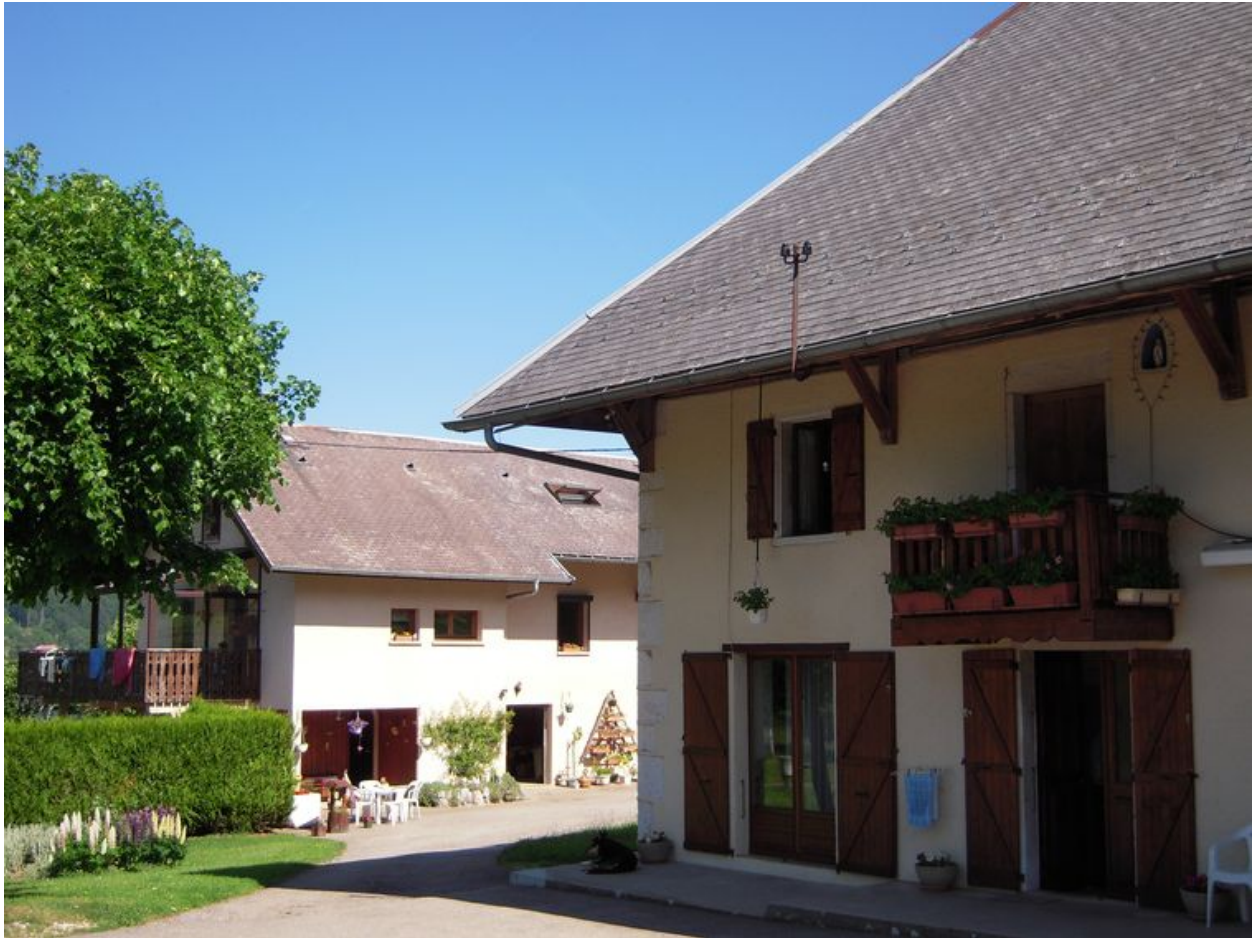
Vue de l'extrémité ouest du bâtiment principal et aperçu du bâtiment annexe transformé en habitation.
