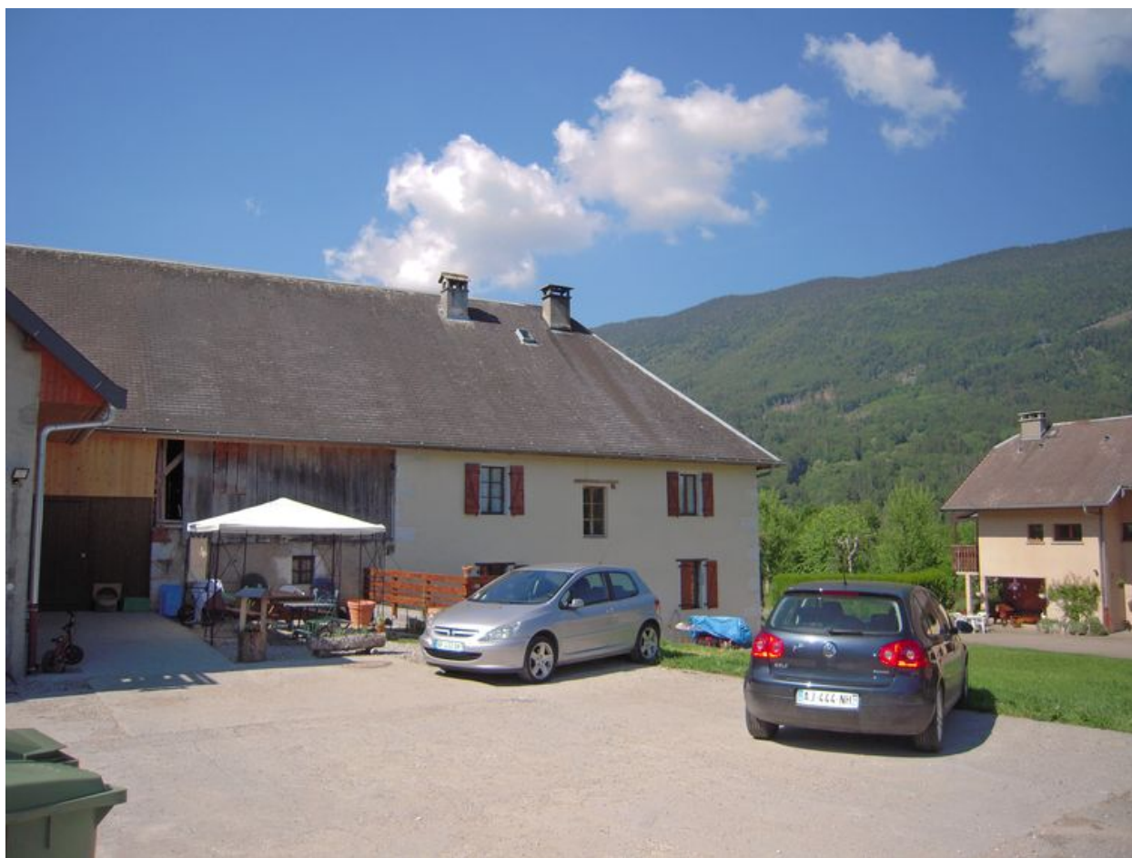
Vue de la façade nord.
