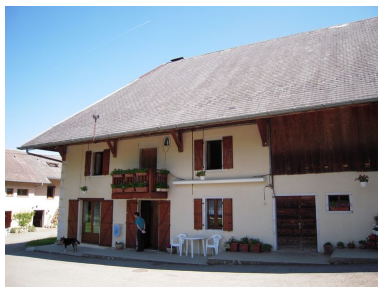
Vue du logis et de l'ancienne étable. Phot. Clémence Serve IVR82_20117400832NUCA
