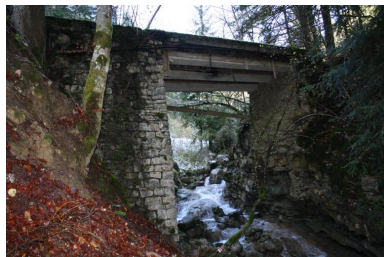
Vieux pont des Landoz, face aval IVR84_20197401279NUCA
