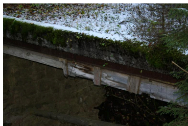
Vieux pont des Landoz, détails poutre acier et renfort bois Phot. Benoît Huraut IVR84_20207401260NUCA
