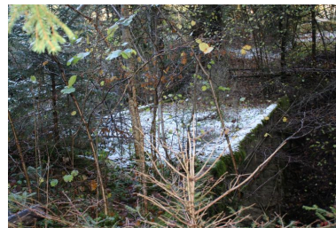
Vieux pont des Landoz, chaussée et gardes corps Phot. Benoît Huraut IVR84_20207401259NUCA
