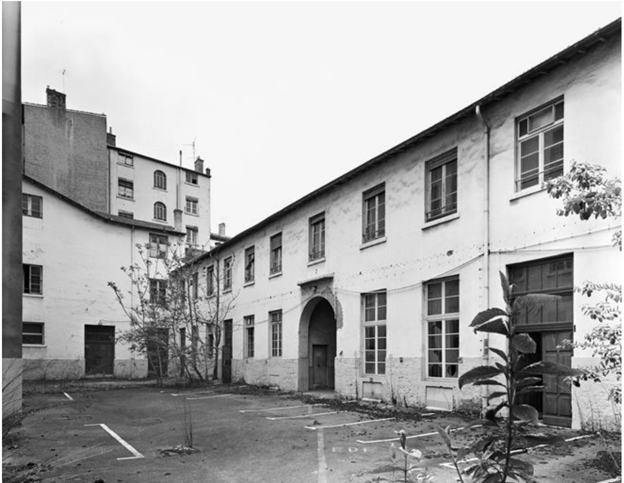
Cour 008, vue générale vers le nord
