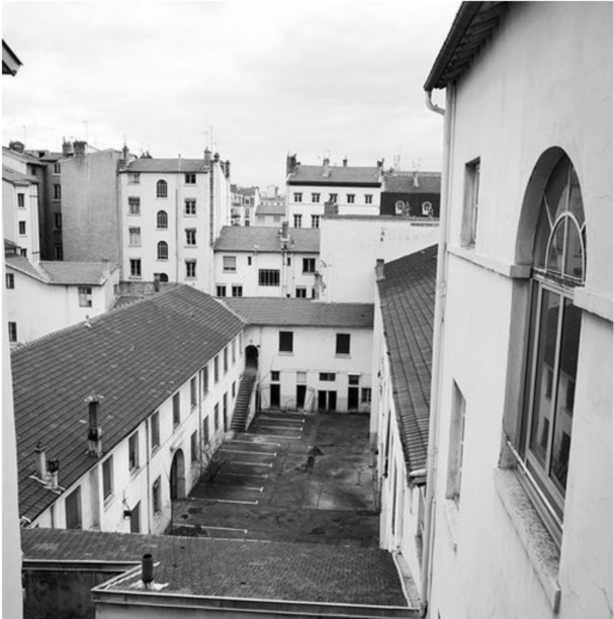
Cour 005, vue générale vers le nord
