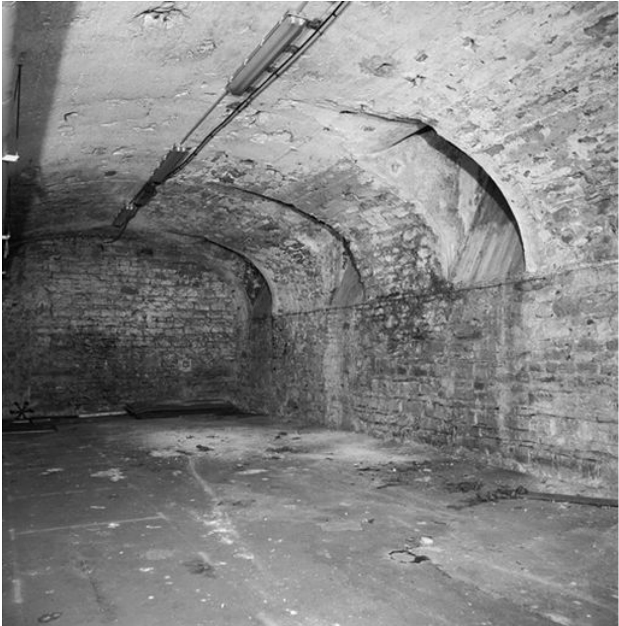
Sous-sol du bâtiment central, vue de la pièce 08
