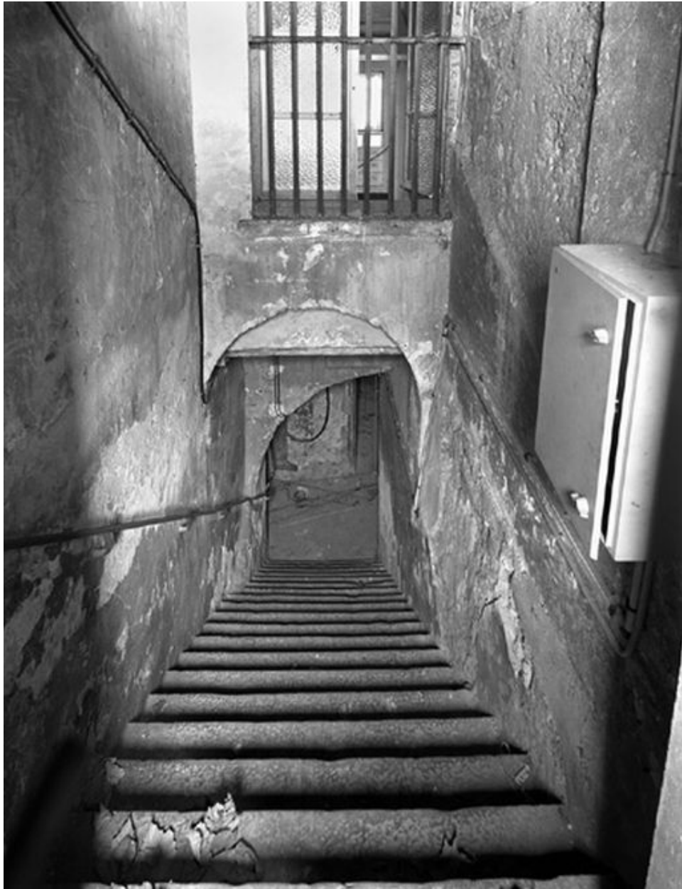
Bâtiment sur la place Carnot, escalier du sous-sol (29)
