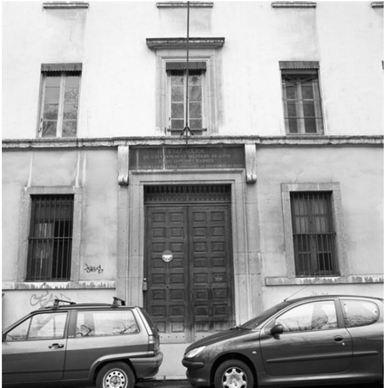
Ancien immeuble, façade sur la place, détail du portail
