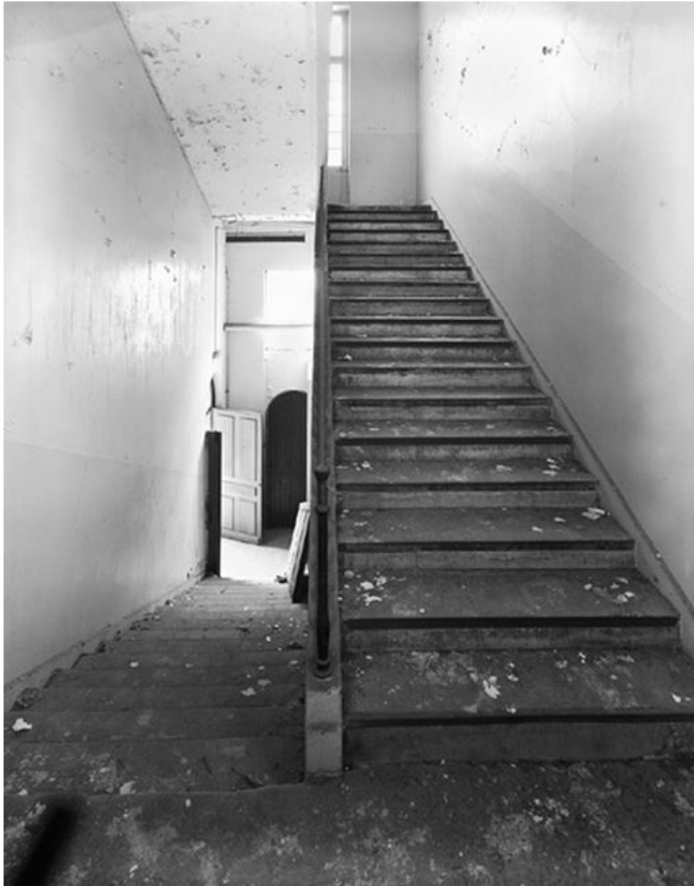
Bâtiment sur la place Carnot, escalier vu depuis le repos de l'entresol
