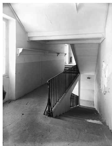
Escalier du corps de liaison nord- ouest, vu depuis le palier du 1er étage Phot. Jean-Marie Refflé IVR82_20026902380V
