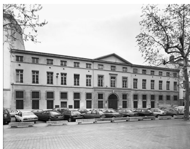
Façade principale sur la place Phot. Jean-Marie Refflé IVR82_20026902358V
