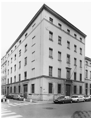
Ancien immeuble, vue générale Phot. Jean-Marie Refflé IVR82_20026902359V
