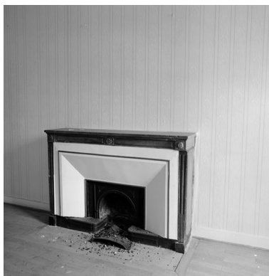
Ancien immeuble, 2e étage, cheminée d'une pièce donnant sur la rue (calcaire à gryphées du Mont d'Or) Phot. Jean-Marie Refflé IVR82_20026902376X
