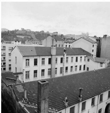
Corps central et bâtiment sur la rue d'Enghien Phot. Jean-Marie Refflé IVR82_20026902364X
