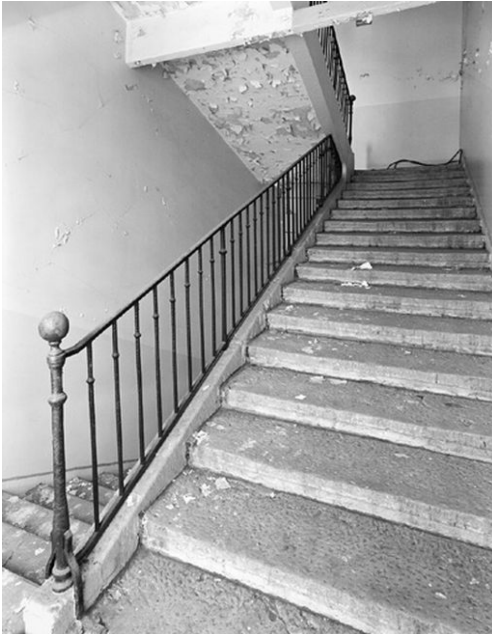
Bâtiment sur la place Carnot, escalier vu depuis le palier du 1er étage
