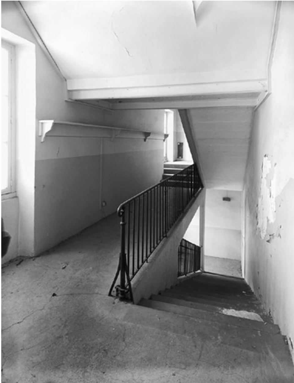
Escalier du corps de liaison nord-ouest, vu depuis le palier du 1er étage
