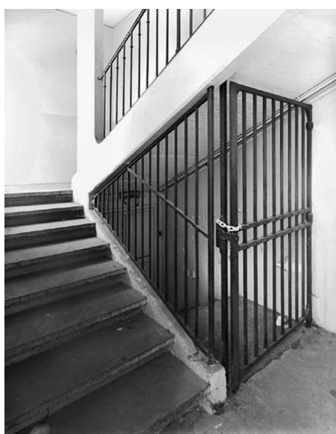
Escalier du corps de liaison nord- ouest, vu depuis le rez-de-chaussée Phot. Jean-Marie Refflé IVR82_20026902379V
