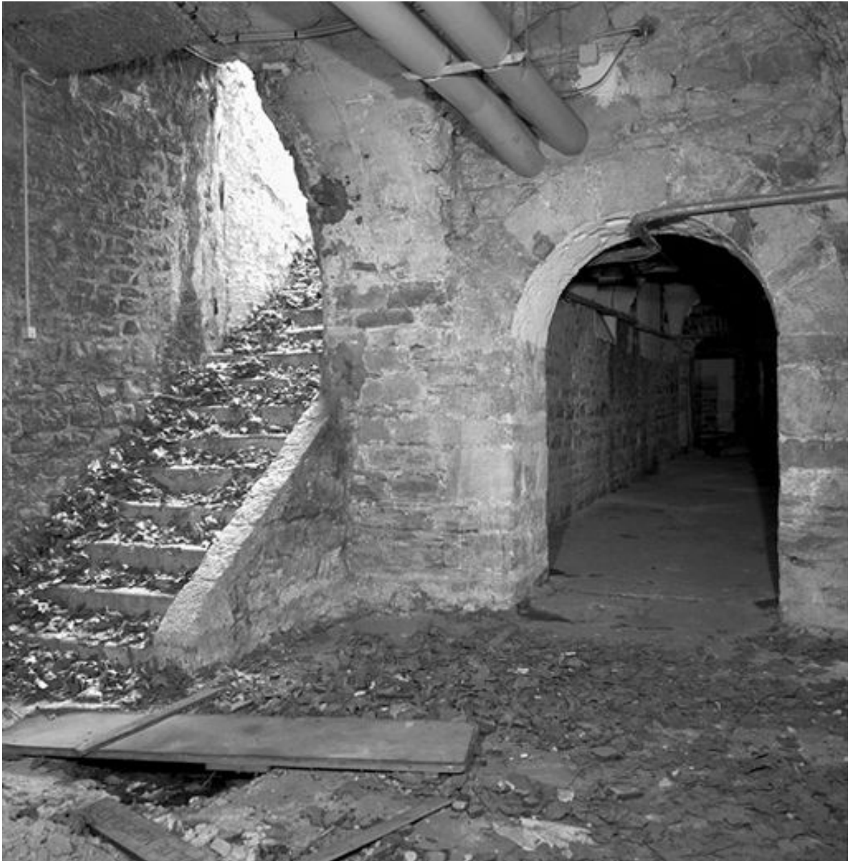
Sous-sol du bâtiment central, escalier et passage sous le corps de liaison sud-est
