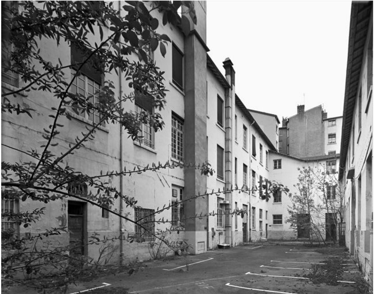
Corps de bâtiment sur la rue d'Enghien, façade sur cour
