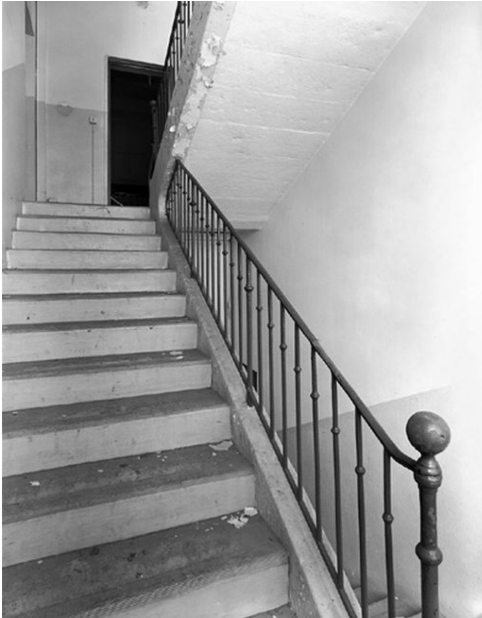
Ancien immeuble, escalier sur cour vu depuis le repos entre le 1er et le 2e étage
