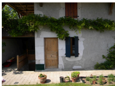
Détail de l'entrée du logis. Phot. Jérôme Daviet IVR82_20127400547NUCA
