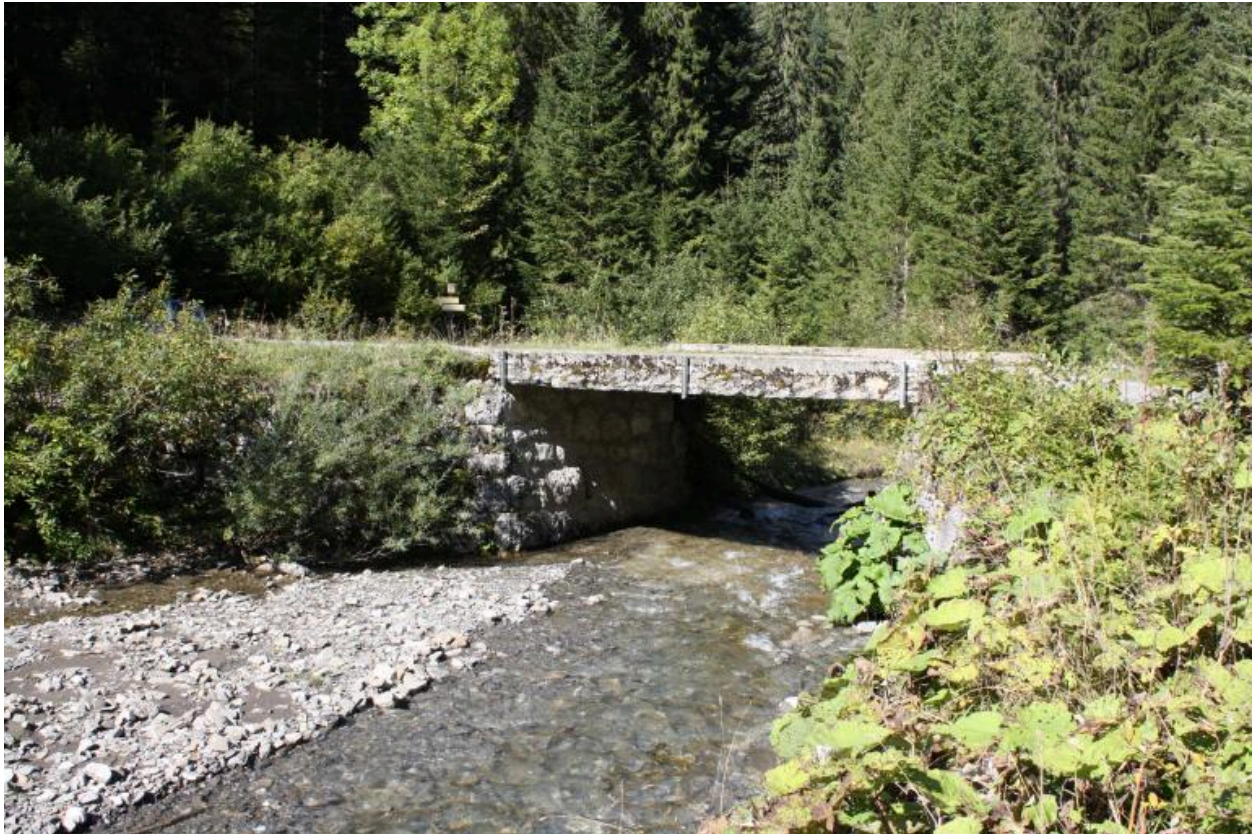
Pont de Chardonnière, contexte et face amont
