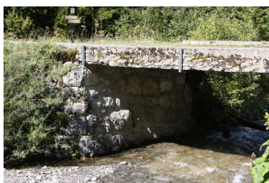
Pont de Chardonnière, détails culée et tablier Phot. Benoît Huraut IVR84_20197401325NUCA
