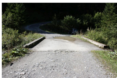
Pont de Chardonnière, chaussée Phot. Benoît Huraut IVR84_20197401324NUCA
