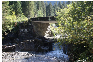
Pont de Chardonnière, face aval Phot. Benoît Huraut IVR84_20197401323NUCA
