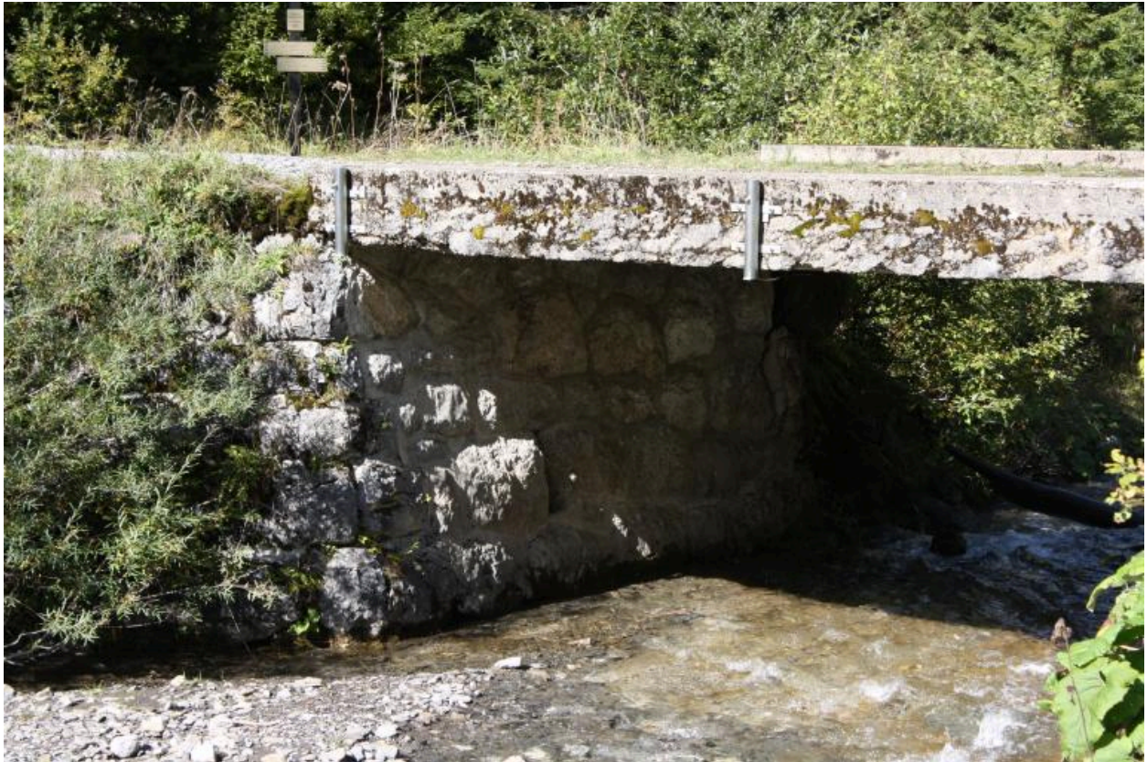
Pont de Chardonnière, détails culée et tablier
