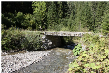
Pont de Chardonnière, contexte et face amont Phot. Benoît Huraut IVR84_20197401255NUCA
