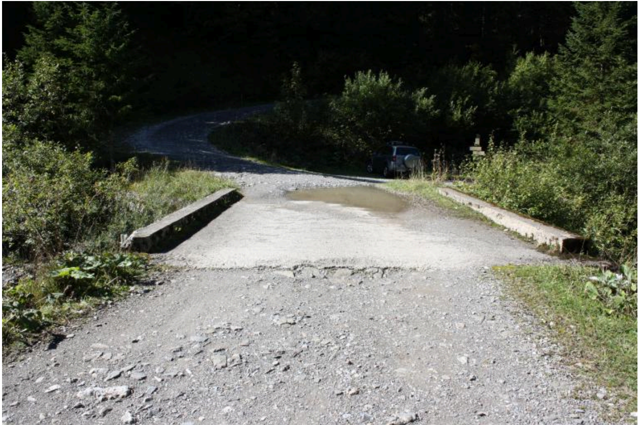
Pont de Chardonnière, chaussée
