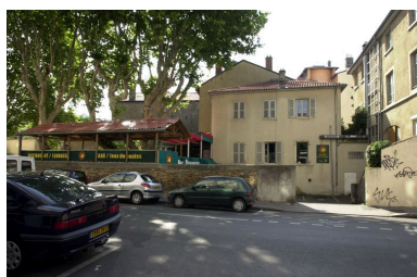
Vue de la cour et du corps de bâtiment rue de Créqui. Etat en 2007 Phot. Maryannick Chalabi IVR82_20106903645NUCA
