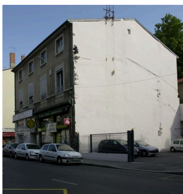
Elévation rue de la Guillotière. Vue d'ensemble depuis le sud-est. Etat en 2007 Phot. Maryannick Chalabi IVR82_20106903643NUCA
