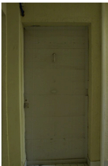
Porte palière. Etat en 2007 Phot. Maryannick Chalabi IVR82_20106903649NUCA
