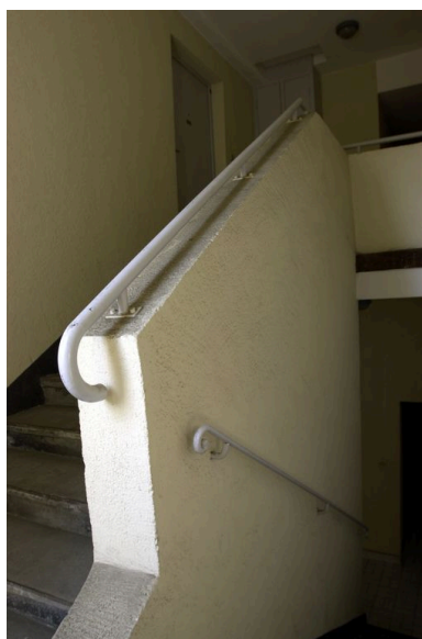
Escalier : arrivée du mur noyau au dernier étage. Etat en 2007 Phot. Maryannick Chalabi IVR82_20106903648NUCA
