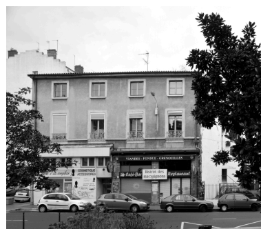
Elévation antérieure Phot. Eric Dessert IVR82_20076901323NUC
