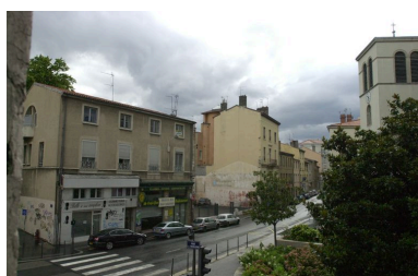
Elévation rue de la Guillotière. Vue d'ensemble depuis le sud-ouest. Etat en 2007 Phot. Maryannick Chalabi IVR82_20106903642NUCA
