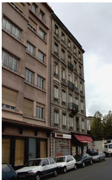
Elévation latérale, quai Perrache Phot. Bernard Ducouret IVR82_20006900616NUCA
