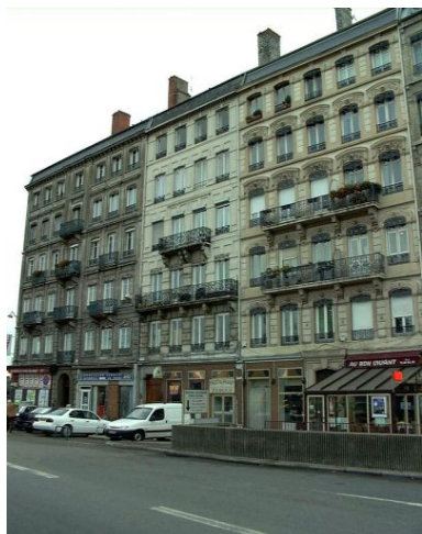
Vue d'ensemble des 36, 38, 40 cours de Verdun-Perrache Phot. Bernard Ducouret IVR82_20006900654NUCA
