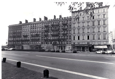
Vue d'ensemble des immeubles, 30-40 cours de Verdun-Perrache Phot. Jean-Marie Refflé IVR82_20016902480V
