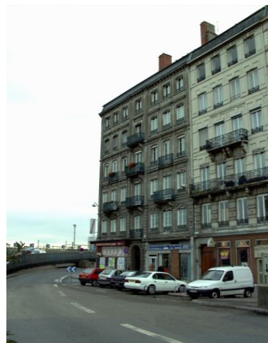
Elévation principale, cours de Verdun-Perrache Phot. Bernard Ducouret IVR82_20006900615NUCA
