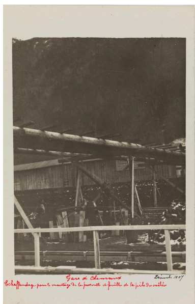
Gare de Chamonix, échafaudage pour le montage de la passerelle. 1907 (AD Haute-Savoie : 36 Fi 530) IVR84_20257401644NUCA
