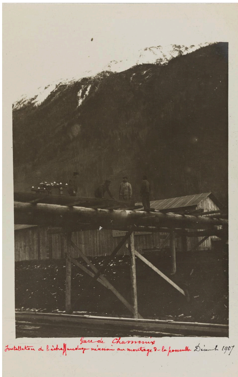
Gare de Chamonix, installation de l'échafaudage. 1907 (AD Haute-Savoie : 36 Fi 529)
