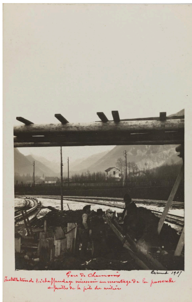
Gare de Chamonix, installation de l'échafaudage. 1907 (AD Haute-Savoie : 36 Fi 528) IVR84_20257401099NUCA
