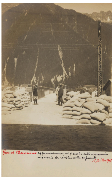
Gare de Chamonix, essais de résistance de la passerelle. 1908 (AD Haute-Savoie : 36 Fi 543) IVR84_20257401607NUCA
