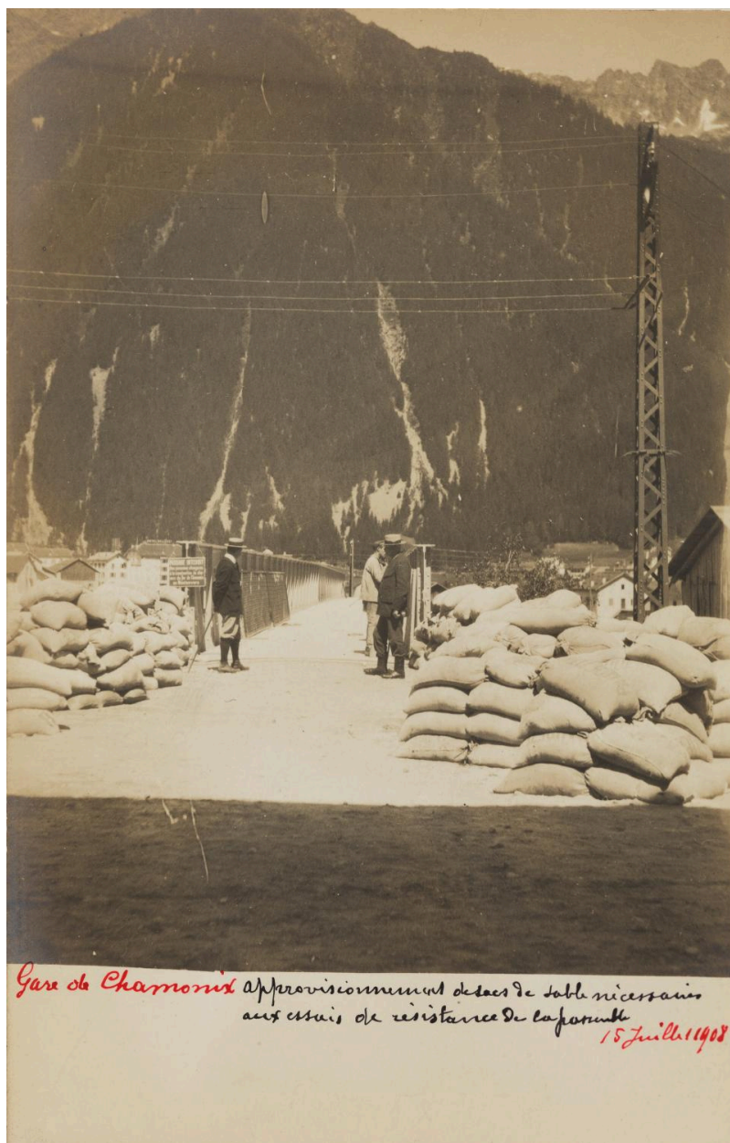
Gare de Chamonix, essais de résistance de la passerelle. 1908 (AD Haute-Savoie : 36 Fi 543)
