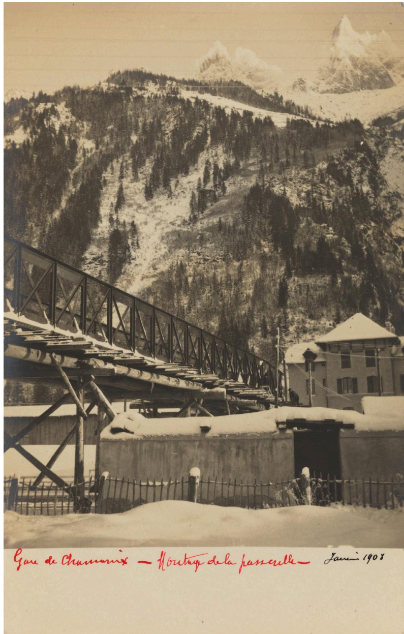
Gare de Chamonix, montage de la passerelle. 1908 (AD Haute-Savoie : 36 Fi 540)
