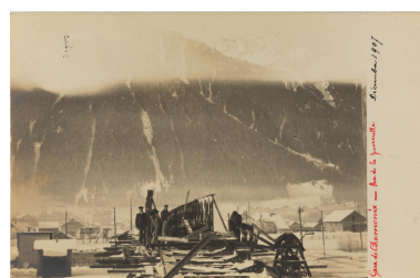
Gare de Chamonix - Montage de la passerelle Démonté 1907
