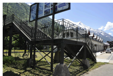
Vue des croix de Saint-André supportant l'escalier Phot. Samir Mahfoudi IVR84_20257401552NUCA
