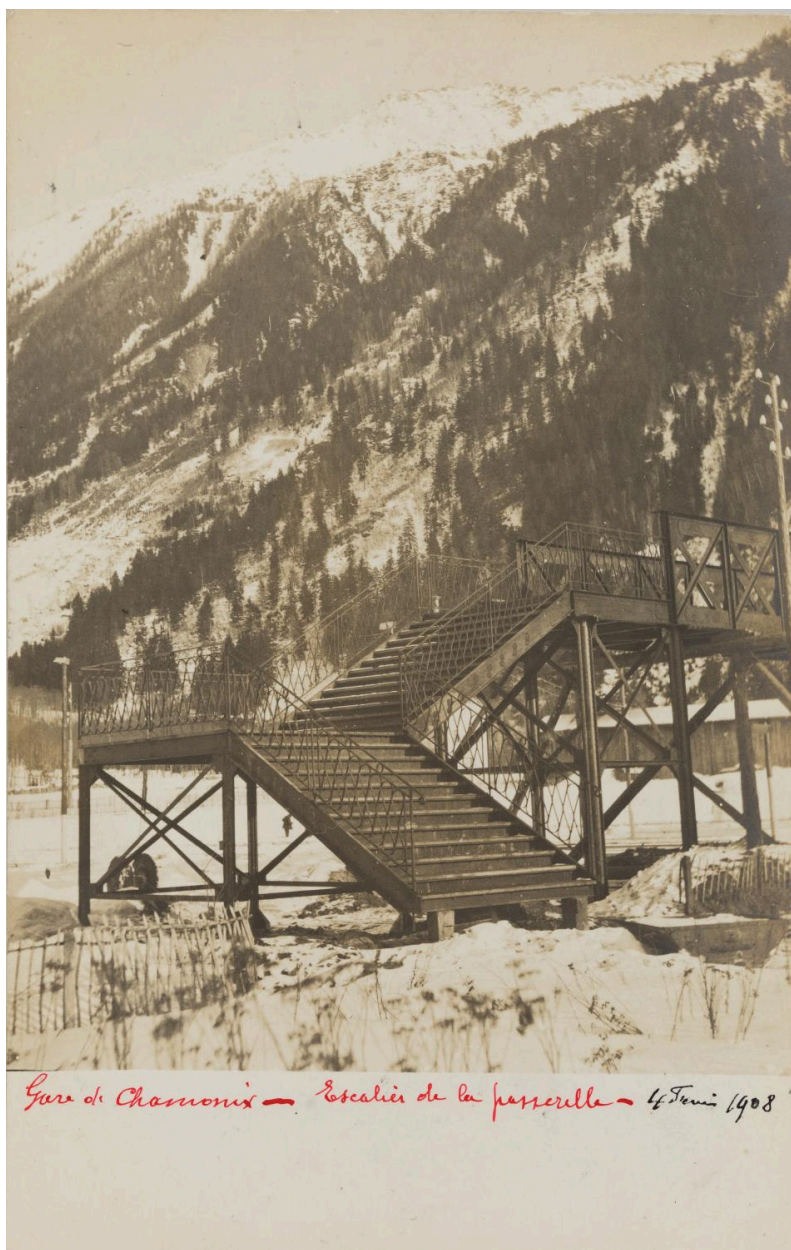
Gare de Chamonix, escalier de la passerelle. 1908 (AD Haute-Savoie : 36 Fi 541)
