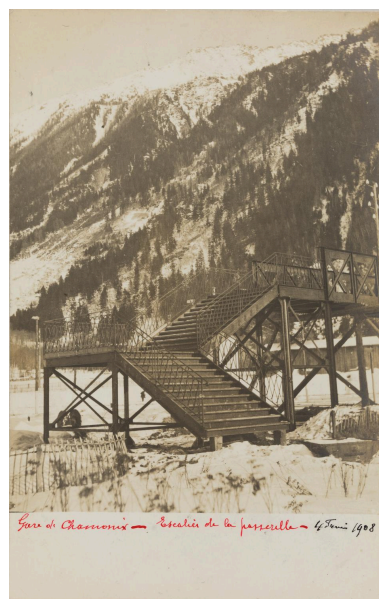
Gare de Chamonix, escalier de la passerelle. 1908 (AD Haute-Savoie : 36 Fi 541) IVR84_20257401605NUCA
