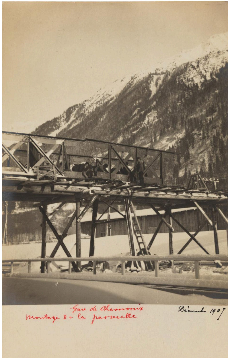
Gare de Chamonix, montage de la passerelle. 1907 (AD Haute-Savoie : 36 Fi 537)
