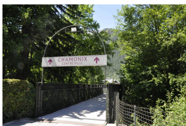
Portique donnant sur l'esplanade de la gare basse du Montenvers Phot. Samir Mahfoudi IVR84_20257401560NUCA
