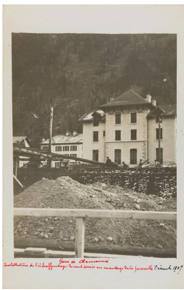
Gare de Chamonix, Installation de l'échafaudage devant servir au montage. 1907 (AD Haute-Savoie : 36 Fi 531) IVR84_20257401645NUCA
