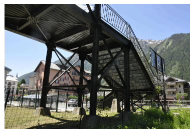
Vue de la passerelle : culée métallique faisant le lien avec l'escalier Phot. Samir Mahfoudi IVR84_20257401555NUCA
