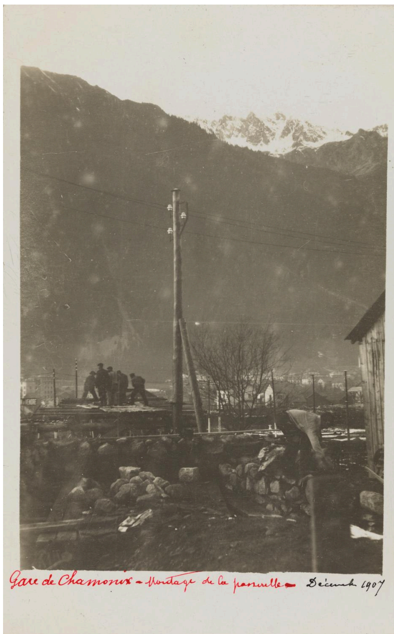
Gare de Chamonix, montage de la passerelle. 1907 (AD Haute-Savoie : 36 Fi 536)
