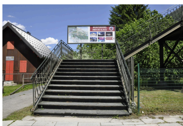
Escalier métallique Phot. Samir Mahfoudi IVR84_20257401557NUCA
