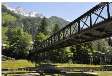
Vue d'ensemble de la passerelle Phot. Samir Mahfoudi IVR84_20257401554NUCA
