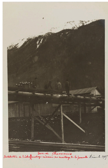
Gare de Chamonix, installation de l'échafaudage. 1907 (AD Haute-Savoie : 36 Fi 529) IVR84_20257401100NUCA
