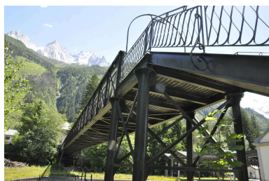
Passerelle métallique du côté de la gare ferroviaire de Chamonix Phot. Samir Mahfoudi IVR84_20257401553NUCA
