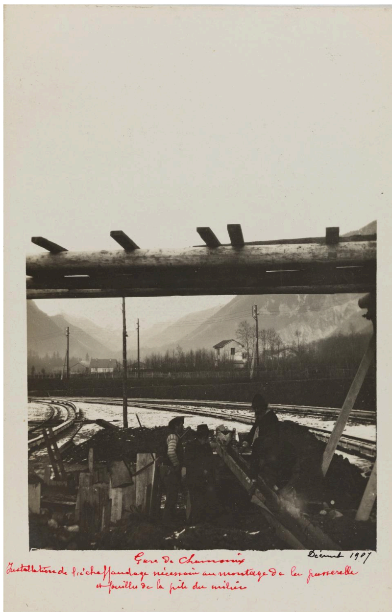
Gare de Chamonix, installation de l'échafaudage. 1907 (AD Haute-Savoie : 36 Fi 528)
