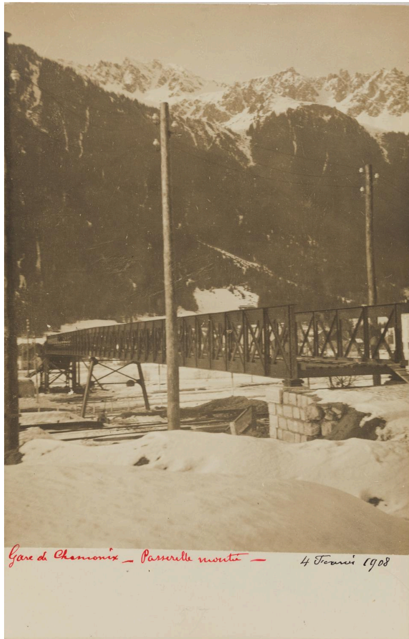
Gare de Chamonix, passerelle montée. 1908 (AD Haute-Savoie : 36 Fi 542)
