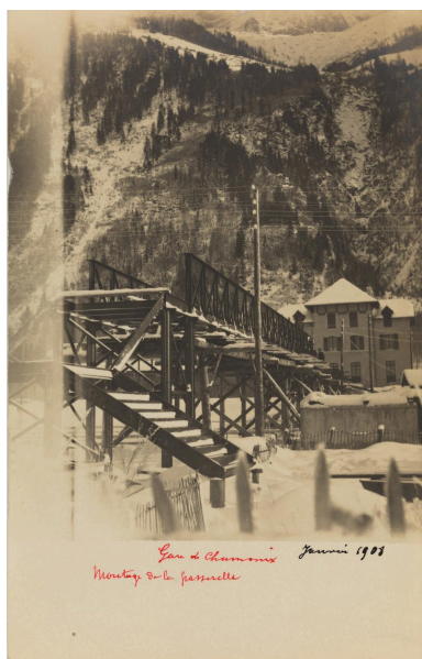
Gare de Chamonix, montage de la passerelle. 1908 (AD Haute-Savoie : 36 Fi 539) IVR84_20257401603NUCA
