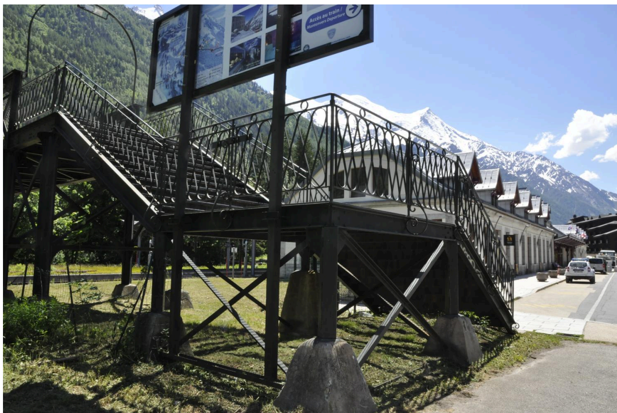
Vue des croix de Saint-André supportant l'escalier
