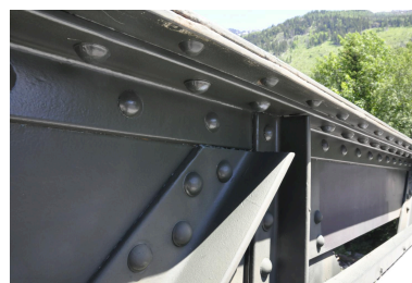
Détail poutre Phot. Samir Mahfoudi IVR84_20257401558NUCA
