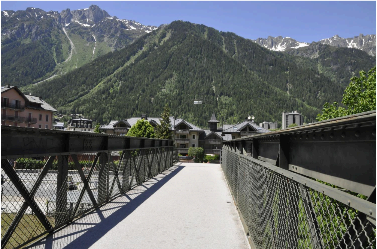
Tablier et garde-corps grillagé de la passerelle
