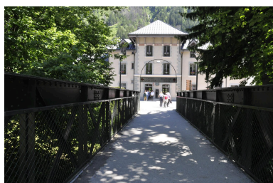
Vue de la gare basse du Montenvers Phot. Samir Mahfoudi IVR84_20257401559NUCA
