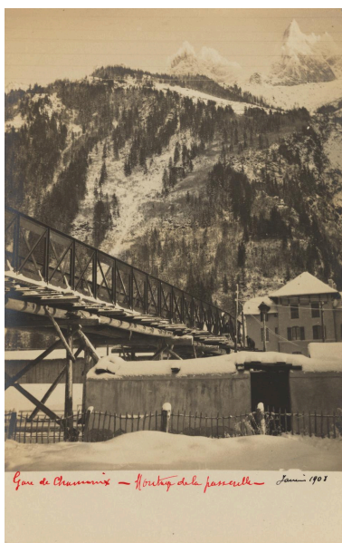
Gare de Chamonix, montage de la passerelle. 1908 (AD Haute-Savoie : 36 Fi 540) IVR84_20257401604NUCA
