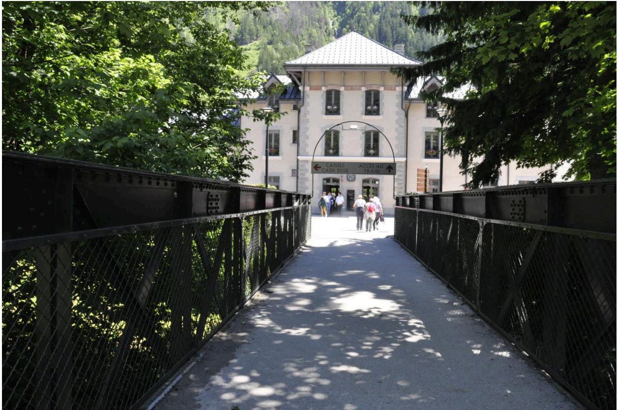
Vue de la gare basse du Montenvers
