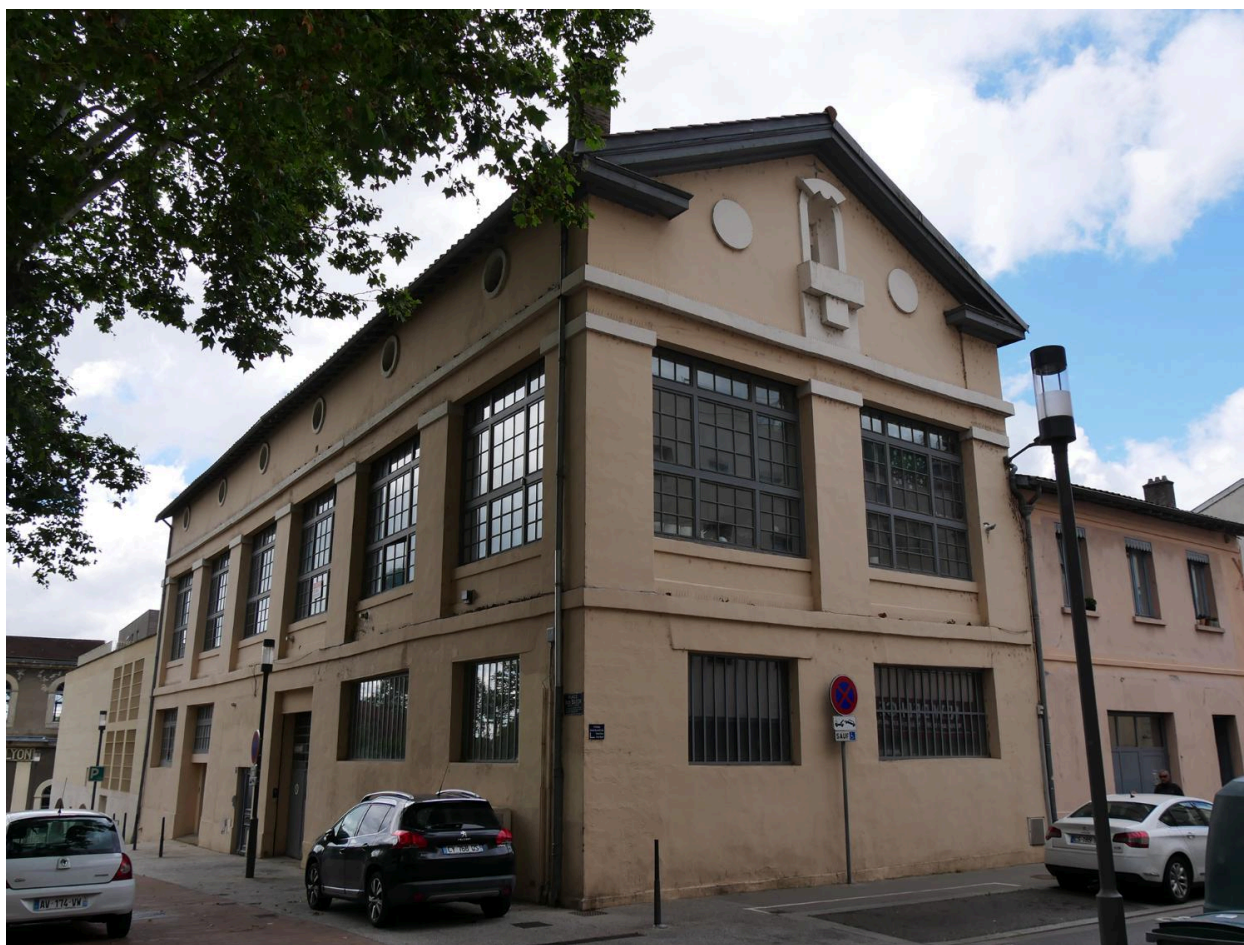
Verrerie Berticat vue nord
