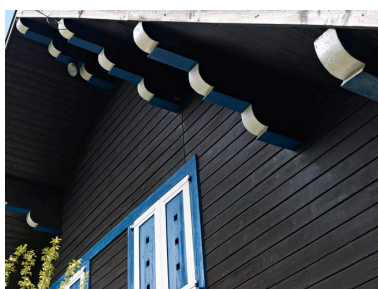
Détail des corbeaux d'avant- toit de la façade sud Phot. Eric Dessert IVR82_20107401302NUCA
