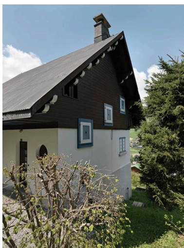
Vue depuis le nord-est Phot. Eric Dessert IVR82_20107401300NUCA
