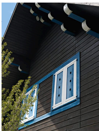
Détail des baies de la façade sud Phot. Eric Dessert IVR82_20107401303NUCA
