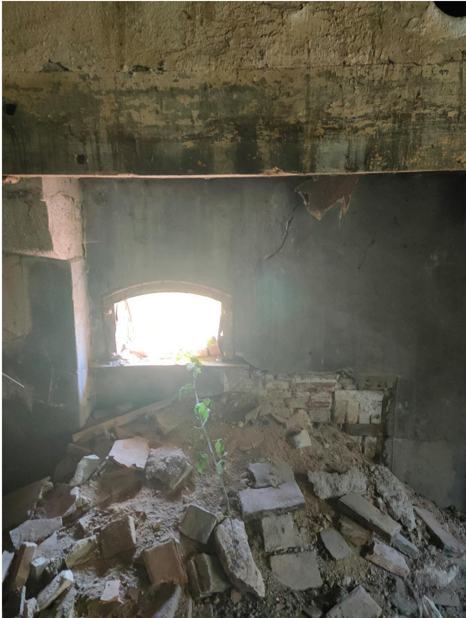
Vue de détail de la cheminée.
