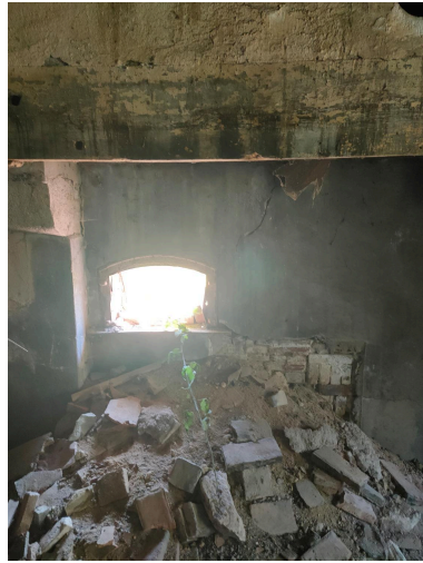
Vue de détail de la cheminée. Phot. Isabelle Brown IVR84_20230300329NUC4A
