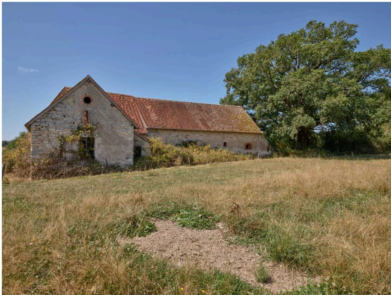
Vue nord de la ferme
