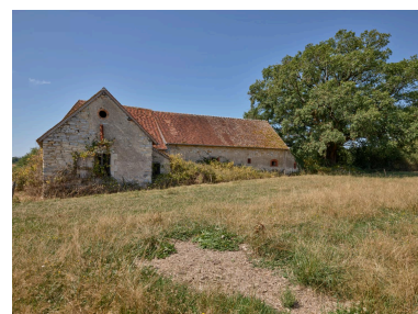
Vue nord de la ferme Phot. Christian Parisey IVR84_20230300278NUC4A
