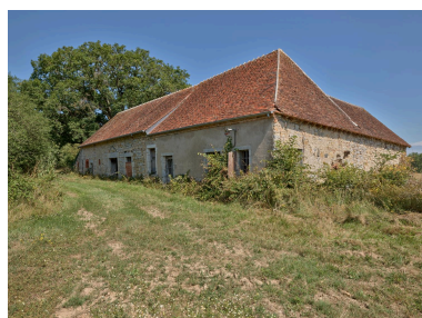
Vue sud-est de la ferme. Phot. Christian Parisey IVR84_20230300276NUC4A
