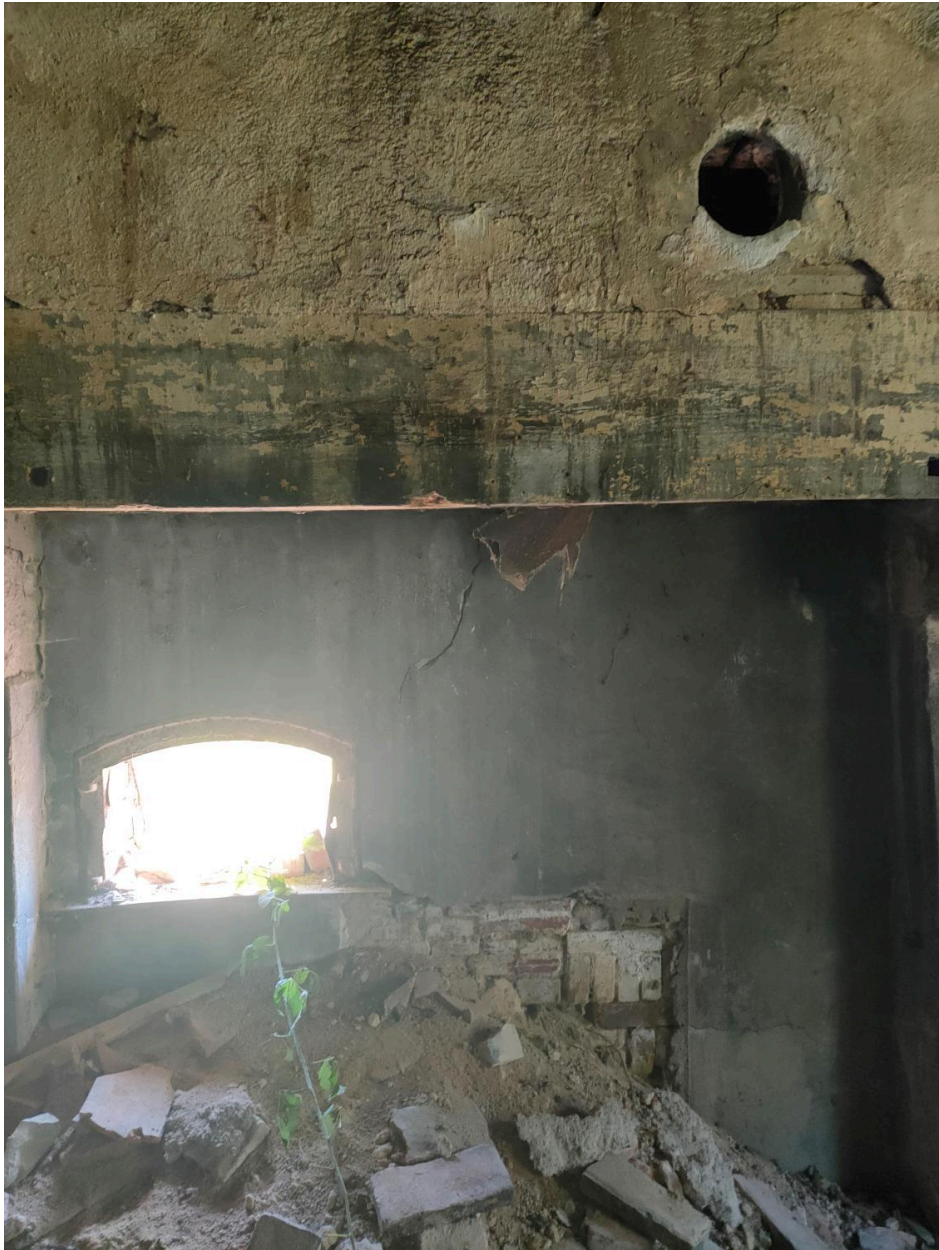
Vue de détail de la cheminée.
