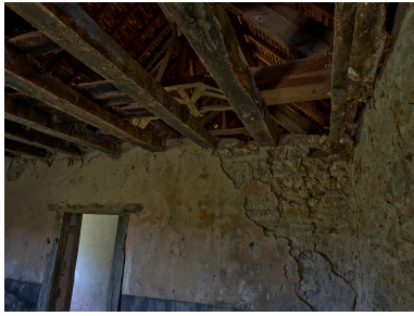
Détail de la charpente : ancienne enrayure de croupe. Phot. Christian Parisey IVR84_20230300277NUC4A
