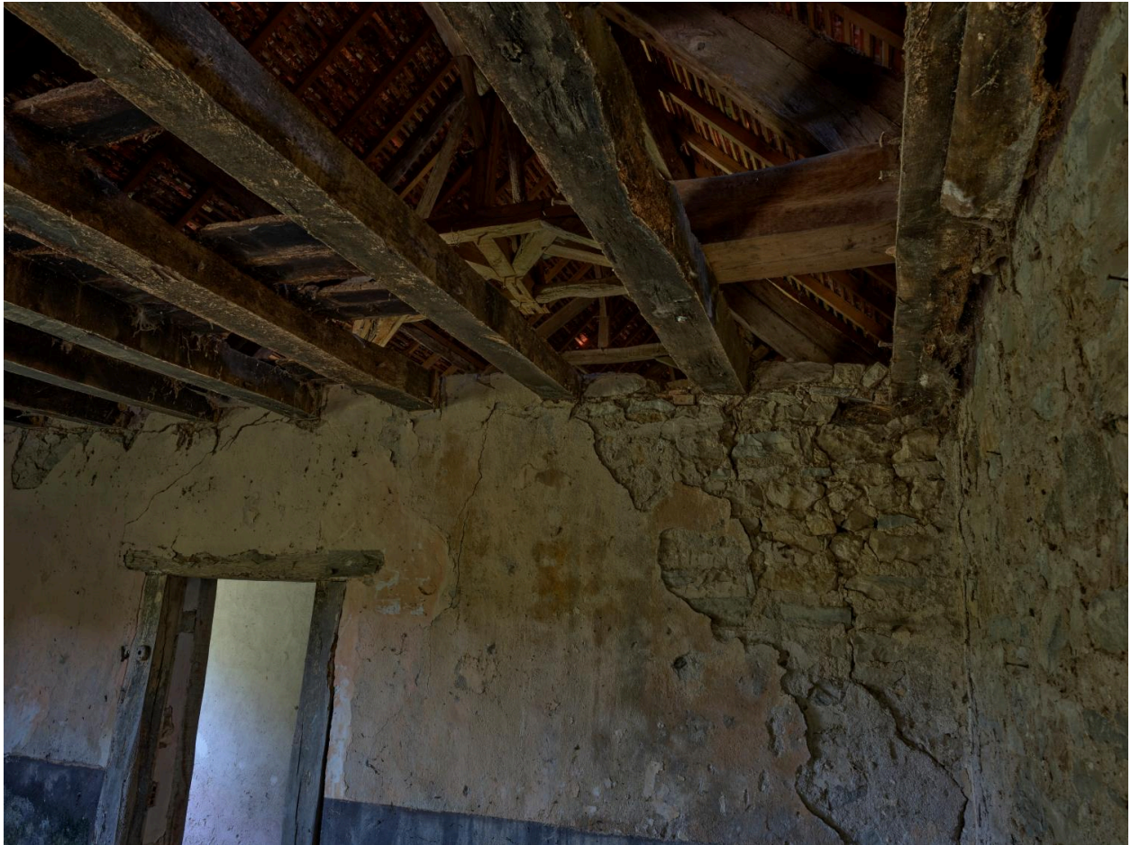
Détail de la charpente : ancienne enrayure de croupe.
