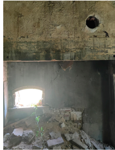
Vue de détail de la cheminée. Phot. Isabelle Brown IVR84_20230300330NUC4A
