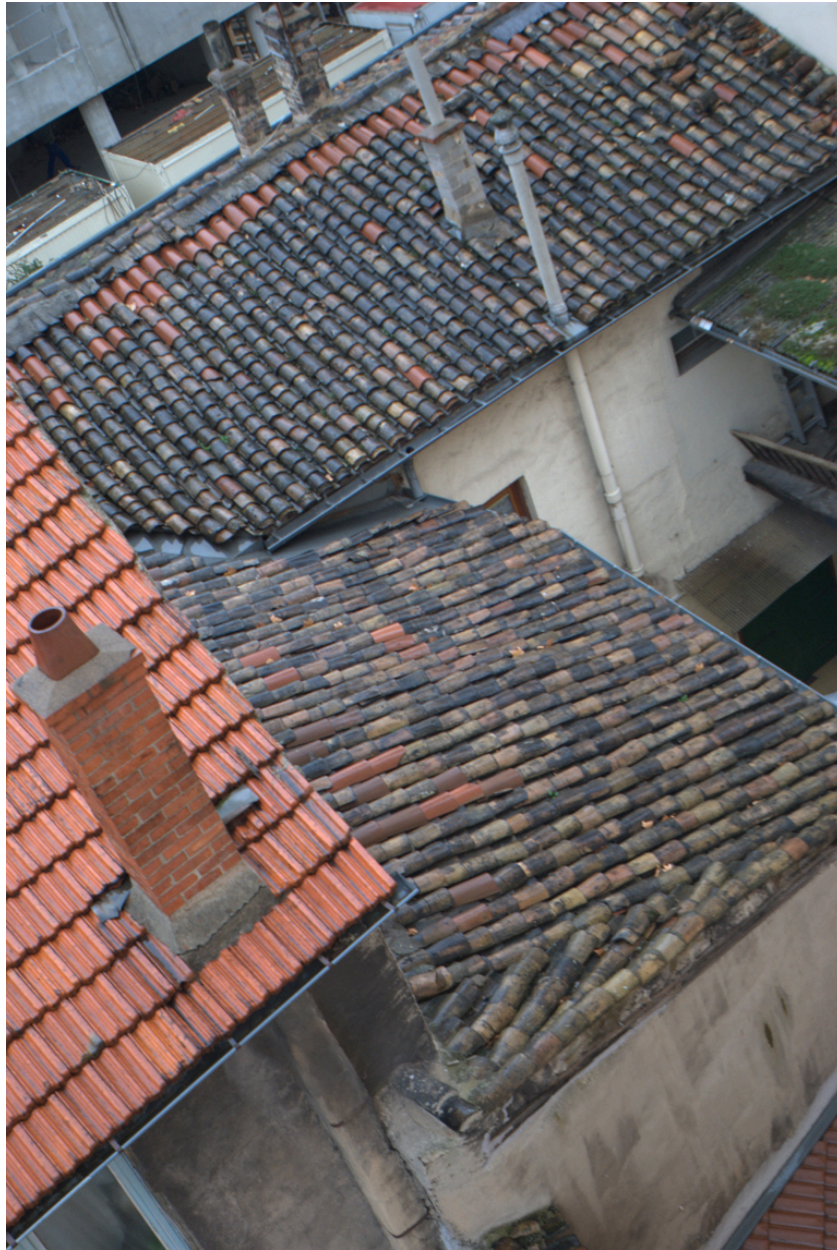
Elévation postérieure, cour et corps de bâtiment en retour
