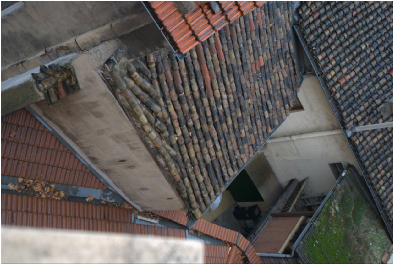
Elévation postérieure, cour et corps de bâtiment en retour
