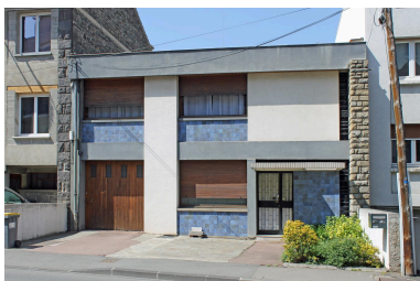
Clermont-Ferrand, la maison V., façade principale, Jean-Paul Bertrand architecte. Phot. Christophe Laurent IVR84_20246301874NUCA
