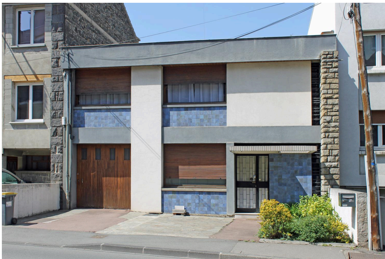
Clermont-Ferrand, la maison V., façade principale, Jean-Paul Bertrand architecte.
