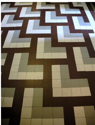
Carrelage du vestibule d'un appartement Phot. Maryannick Chalabi IVR82_20076900406NUCA
