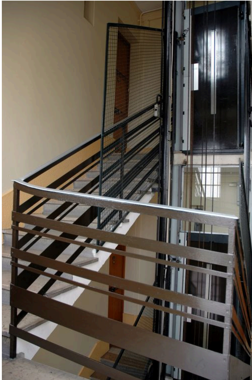
La rampe de l'escalier au niveau d'un repos
