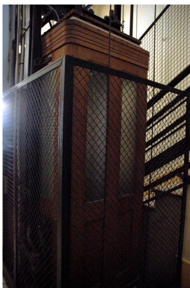
L'ascenseur Phot. Maryannick Chalabi IVR82_20076900398NUCA
