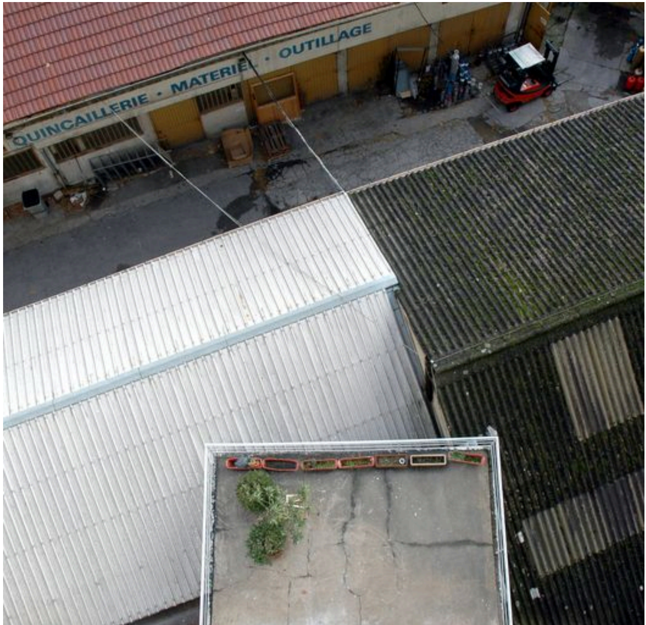
Une des terrasses de la cage d'escalier
