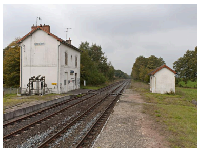
Vue générale de la gare et de l'abri voyageurs de Montbeugny, côté voies. Il s'agit de la première station après le départ de Moulins en direction de Digoin ; elle est toujours en activité. Phot. Jean-Michel Périn IVR83_20150300086NUC4A
