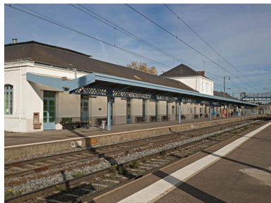
Vue générale de la gare de Moulins, du côté des quais et des voies. Pas plus qu'aucune des gares du réseau ferré auvergnat, la gare de Moulins ne fait l'objet d'une description dans les guides ferroviaires. Phot. Jean-Michel Périn IVR83_20150300090NUC4A
