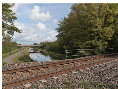
Vue de l'embranchement du canal latéral à la Loire et du pont routier de la N79 en direction de l'écluse de la Besbre, près de Sept-Fons. Ici, trois axes de communication cohabitent donc, la route, la voie d'eau et le chemin de fer. Le canal est en général cité par les guides, lors de sa traversée par la ligne, comme
