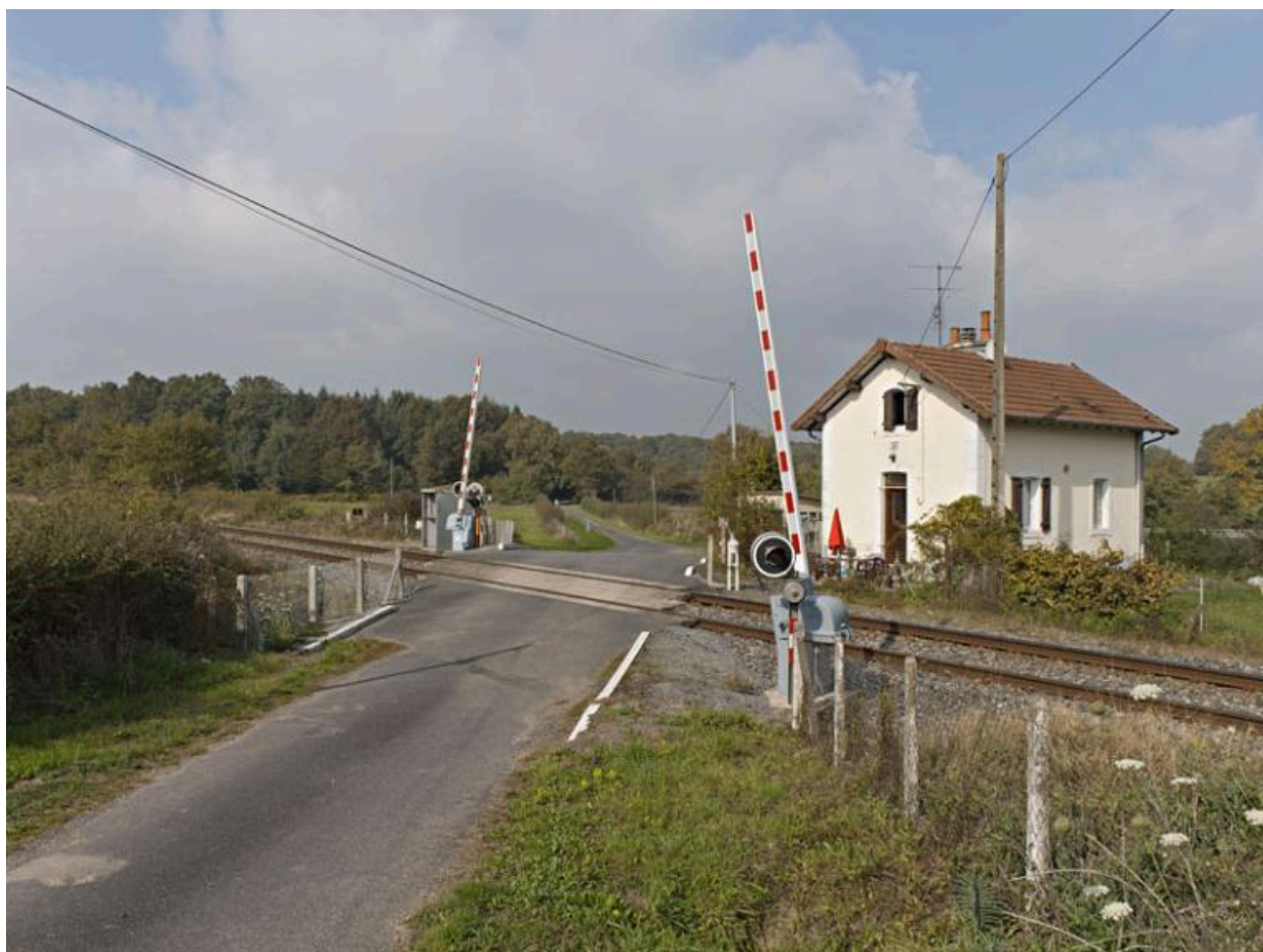
Vue du site de la voie ferrée vers le passage à niveau des Blins, au nord-ouest de Montbeugny.
