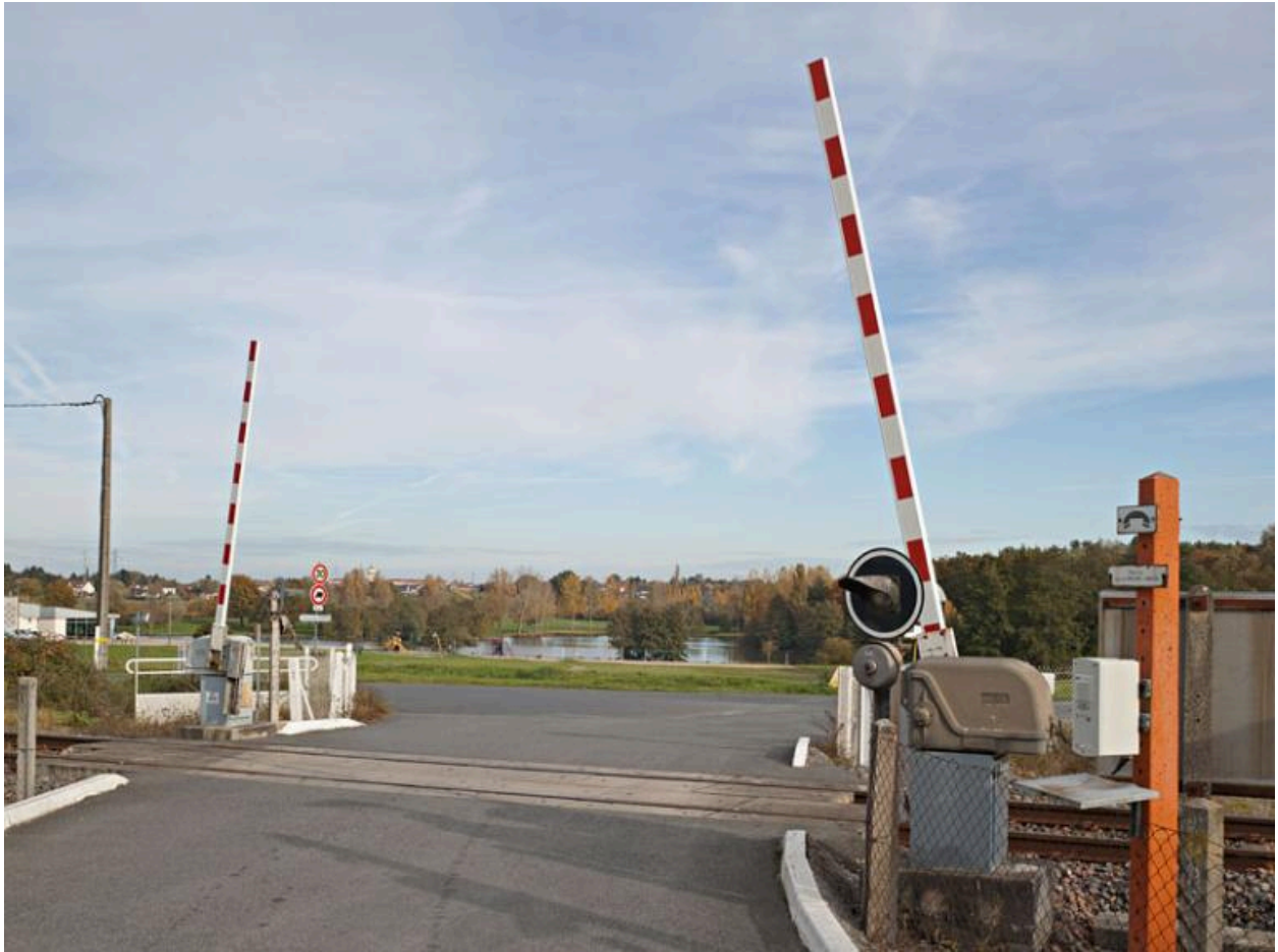
Vue du passage à niveau des Sapins, à proximité de la base de loisirs, au sud-est de Moulins.
