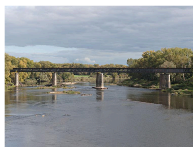
Vue générale du pont ferroviaire sur la Loire, entre Diou (Auvergne) et Gilly-sur-Loire (Bourgogne - Franche-Comté). Seul le guide ferroviaire de 1883 fait allusion à cette traversée du fleuve ; les guides du milieu du XXe s. décrivent seulement le trajet par la route, côté rive gauche.
