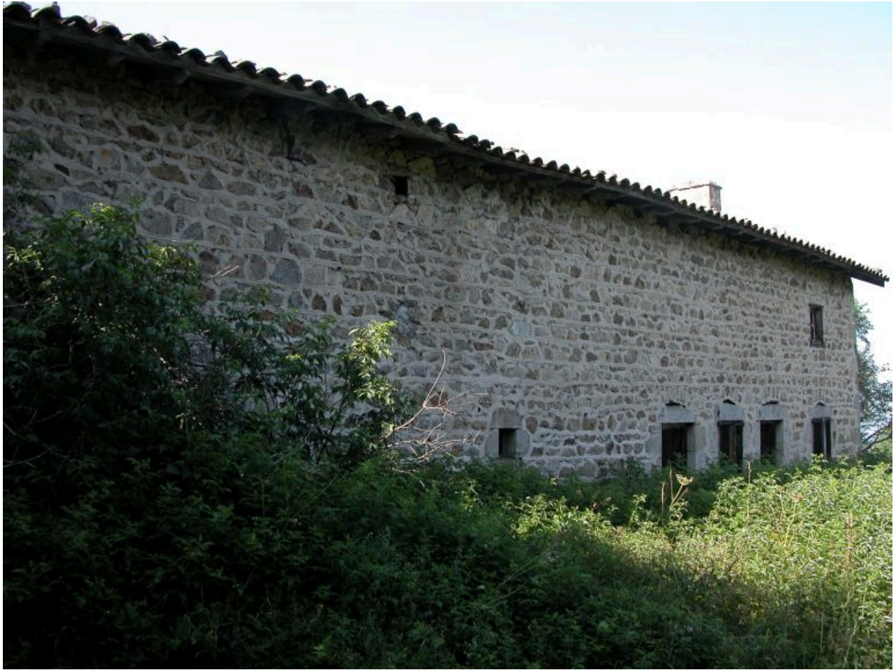
Vue d'ensemble du mur gouttereau sud-est.
