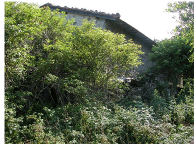
Vue d'ensemble de la cave effondrée depuis le nord. Phot. Thierry Monnet IVR82_20134200049NUCA
