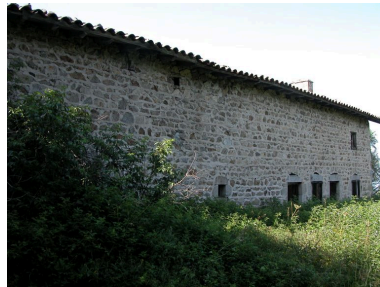
Vue d'ensemble du mur gouttereau sud-est. Phot. Thierry Monnet IVR82_20134200048NUCA
