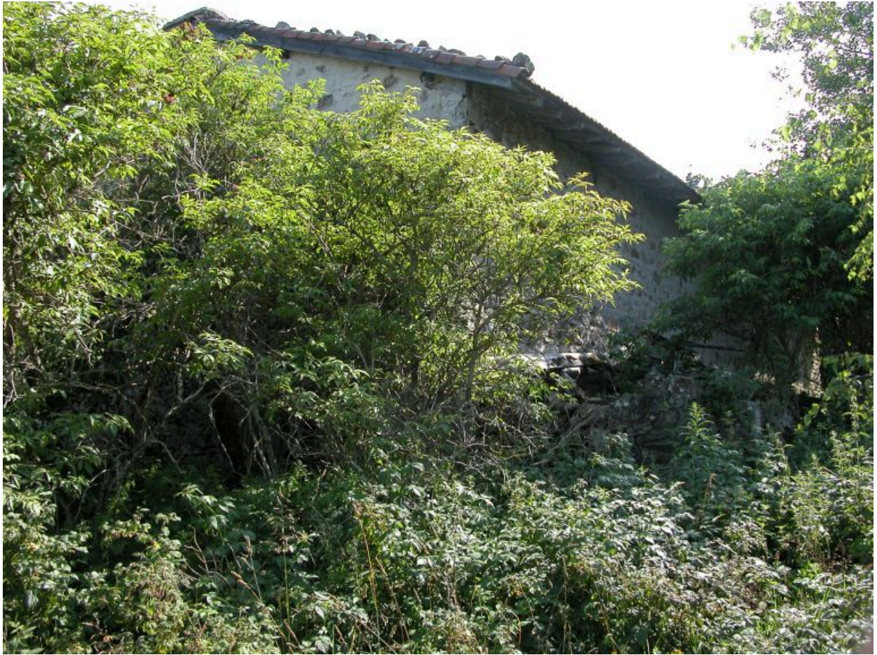
Vue d'ensemble de la cafe effondrée depuis le nord.
