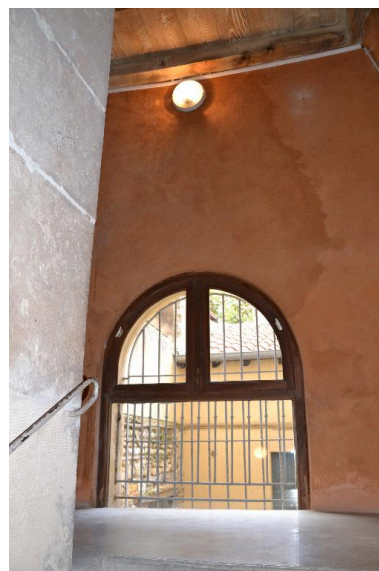
Baie escalier Phot. Noémie Caillat IVR82_20156900175NUCA
