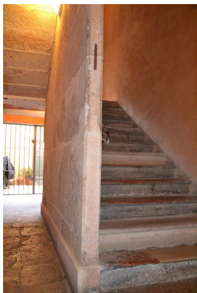
Départ escalier Phot. Noémie Caillat IVR82_20156900173NUCA
