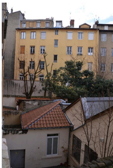
Cour et atelier Phot. Noémie Caillat IVR82_20156900182NUCA
