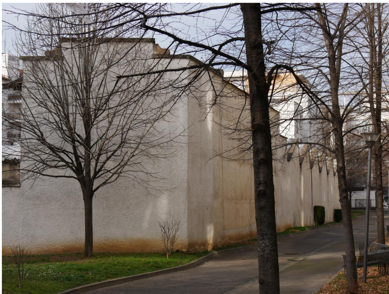
Détail partie sheds
