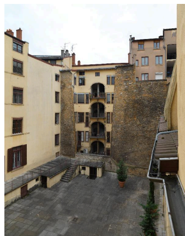
Vue de situation de l'élévation sur cour depuis l'escalier ouest de la commanderie des Antonins Phot. Thierry Leroy
