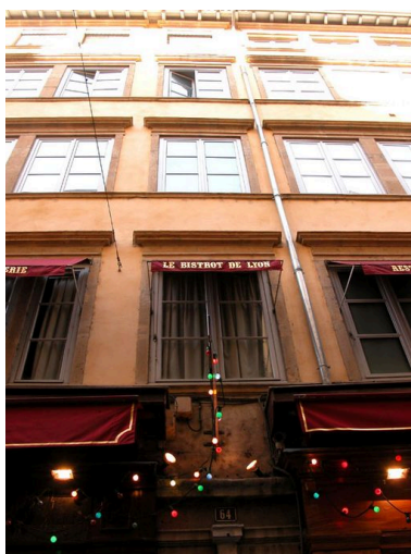
Vue partielle des étages carrés Phot. David Chevallier IVR82_20046905106NUCA
