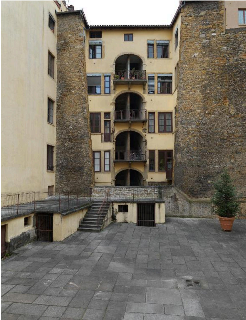
Elévation sur la cour de la commanderie des Antonins
