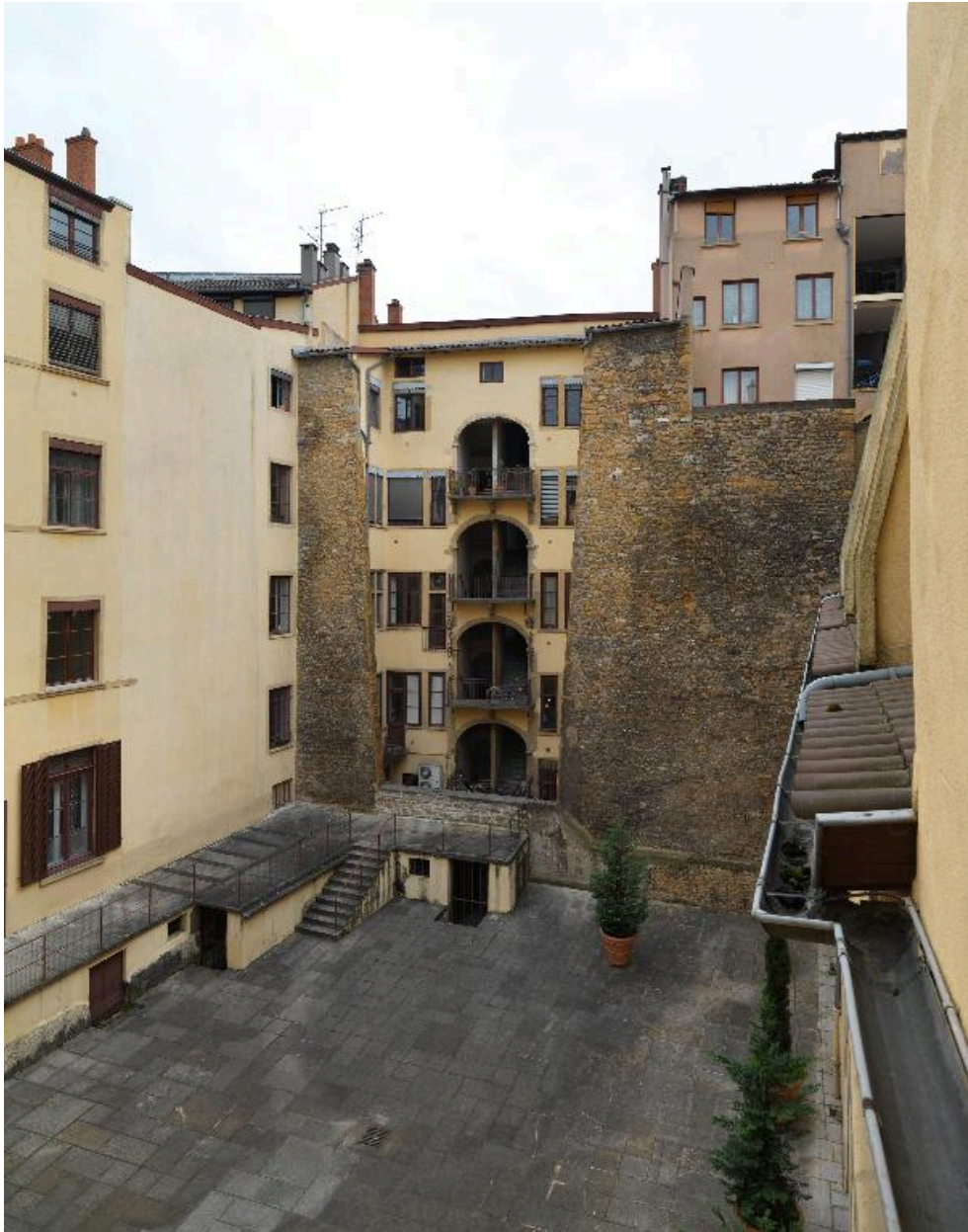
Vue de situation de l'élévation sur cour depuis l'escalier ouest de la commanderie des Antonins
