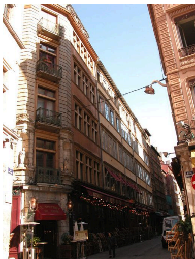
Vue de situation Phot. David Chevallier IVR82_20046905099NUCA
