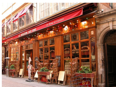
Partie droite du rez-de-chaussée Phot. David Chevallier IVR82_20046905104NUCA
