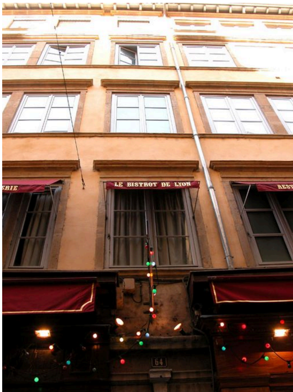
Vue partielle des étages carrés
